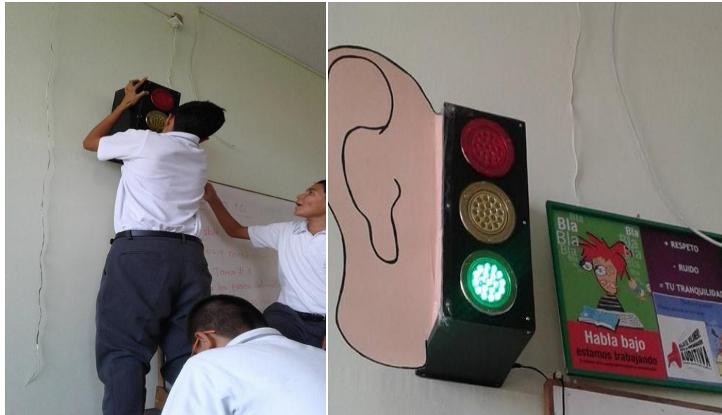
Imagen 8. Instalación del semáforo
