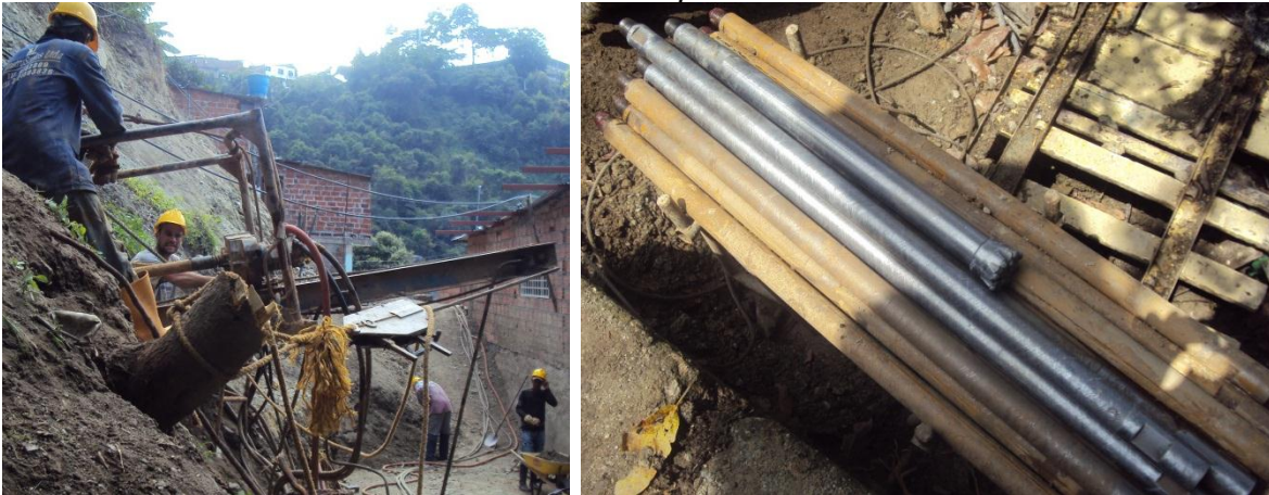
Ilustración 57 Canastilla de perforación con tubería
