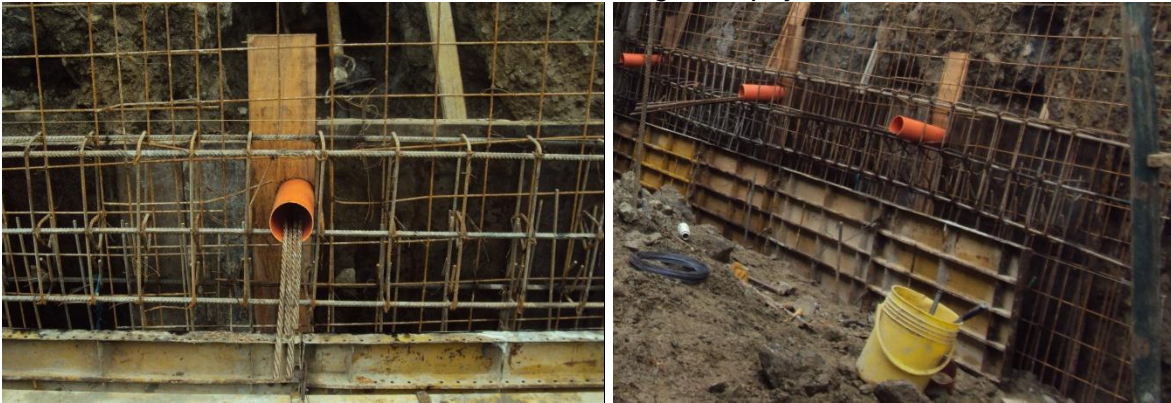
Ilustración 51 Muestra de la viga de apoyo en obra.
