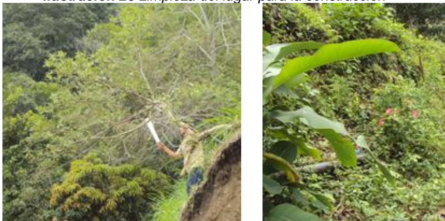
Ilustración 26 Limpieza del lugar para la construcción
