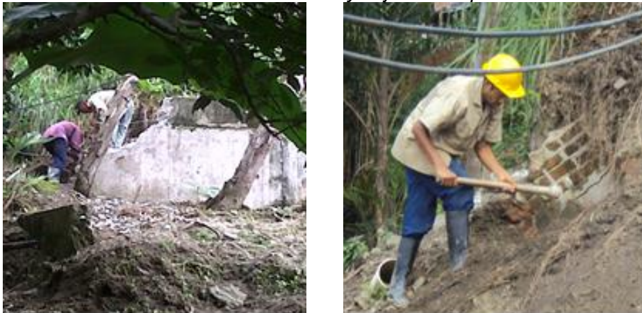
Ilustración 27 Demolición de muros y cajas de inspección existentes
