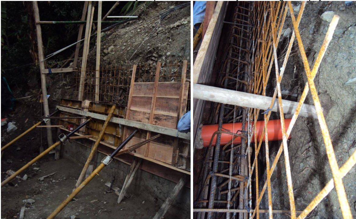
Ilustración 43 Formaleta y disposición de los anclajes en la viga de apoyo
