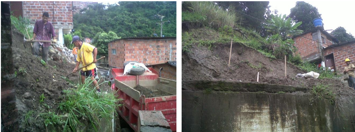
Ilustración 31 Excavación en el lote del señor Humberto Ravelo
