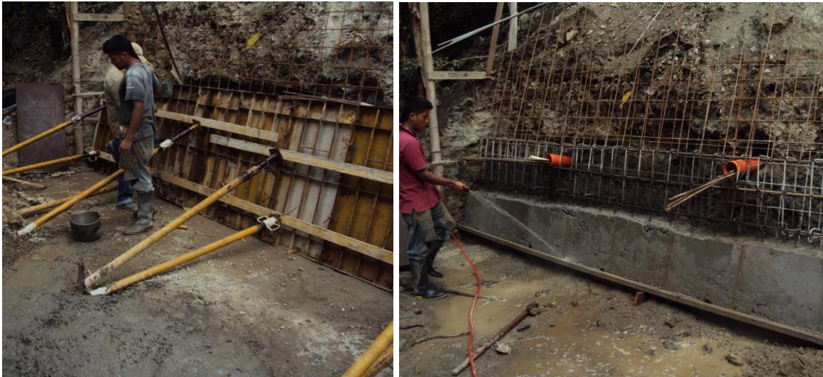
Ilustración 42 Formaleta e hidratación del 1° tramo vertical
