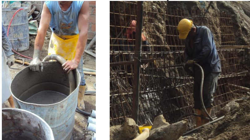
Ilustración 61 Relleno de los anclajes con lechada
