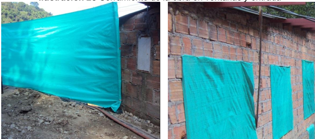
Ilustración 23 Cerramiento de la obra en ventanas y entrada
