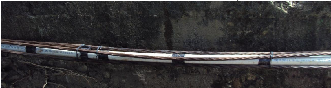
Ilustración 52 Zona de bulbo del anclaje
