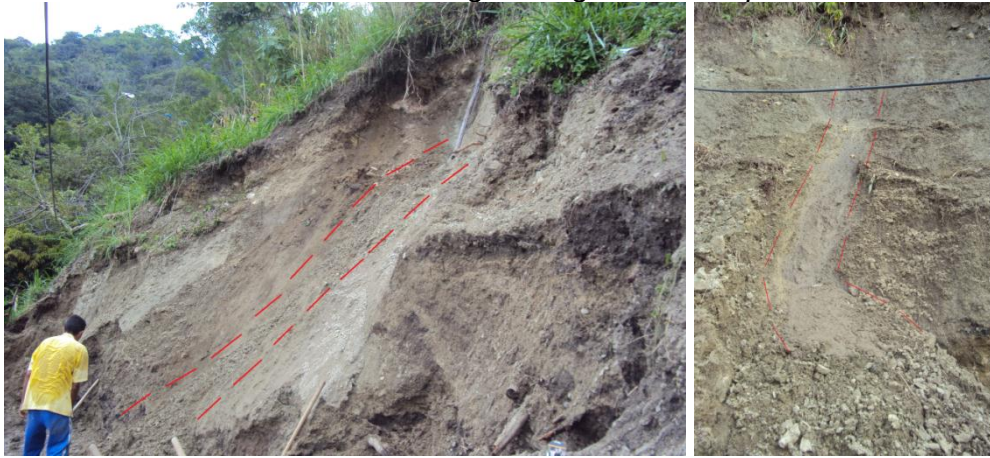
Ilustración 18 Filtración de aguas negras hacia el pie del Talud
