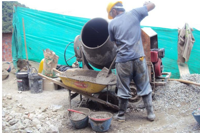
Ilustración 41 Mezcla del concreto en sitio
