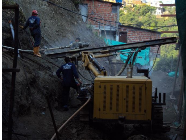
Ilustración 59 Trackdriller en funcionamiento
