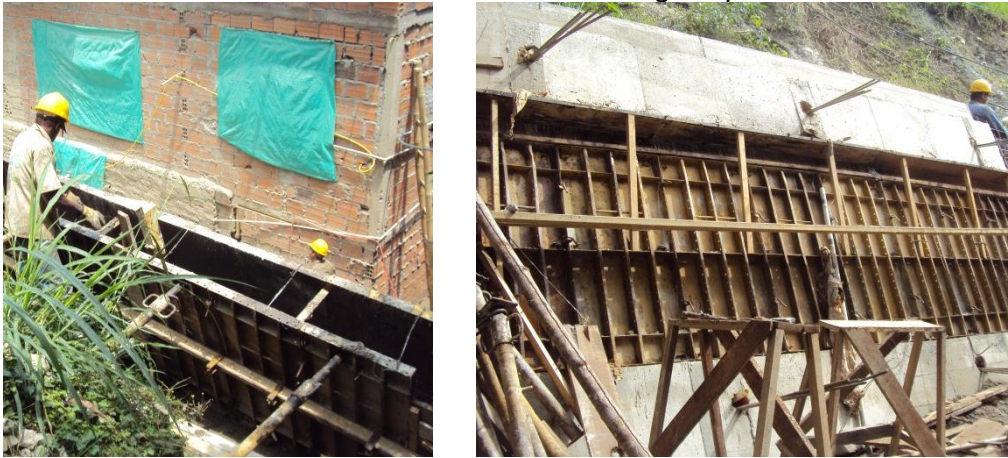
Ilustración 45 Formaleta de la Viga superior
