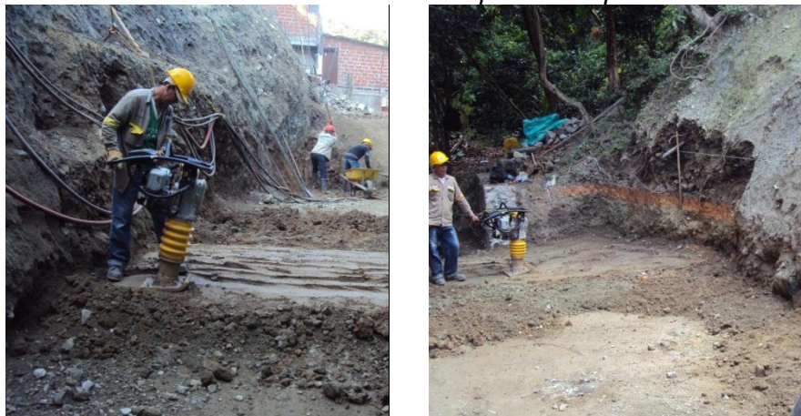
Ilustración 39 Uso del Vibro compactador tipo Saltarín
