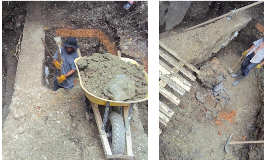
Ilustración 38 Excavación en roca
