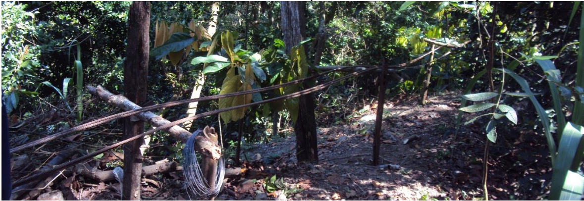
Ilustración 55 Cables utilizados para los torones del anclaje
