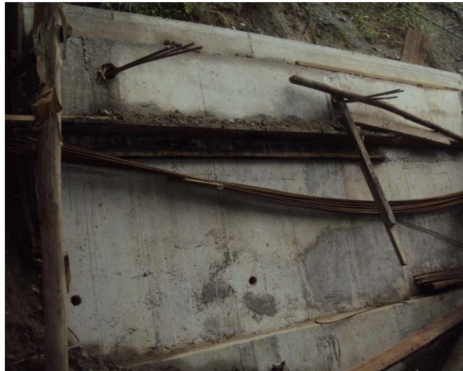
Ilustración 46 Primer tramo horizontal terminado
