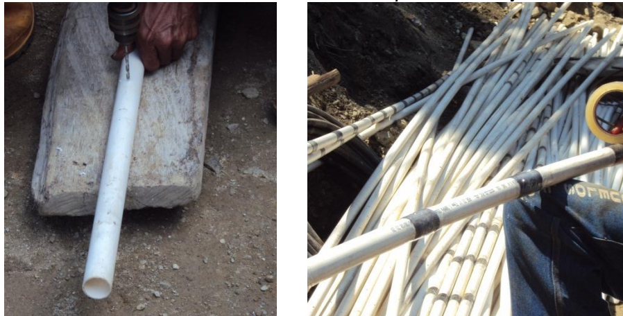
Ilustración 62 Tubería de PVC para el anclaje
