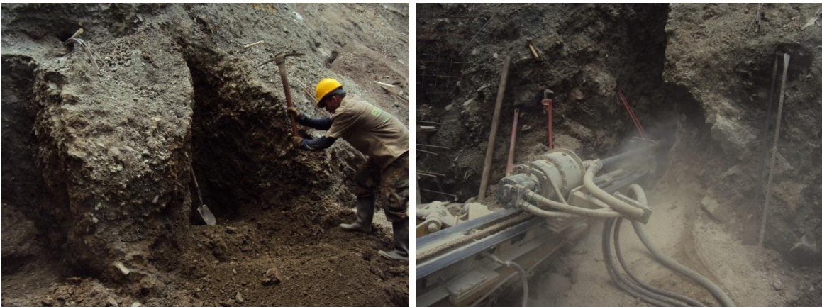
Ilustración 60 Perforaciones inferiores con Trackdriller
