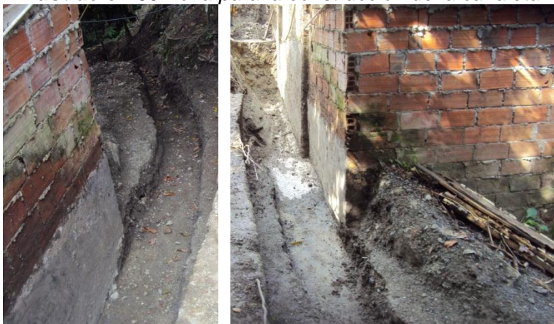
Ilustración 30 Zona para la construcción de la canaleta
