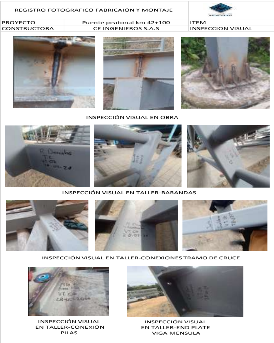
Figura 7. Inspección visual elementos
