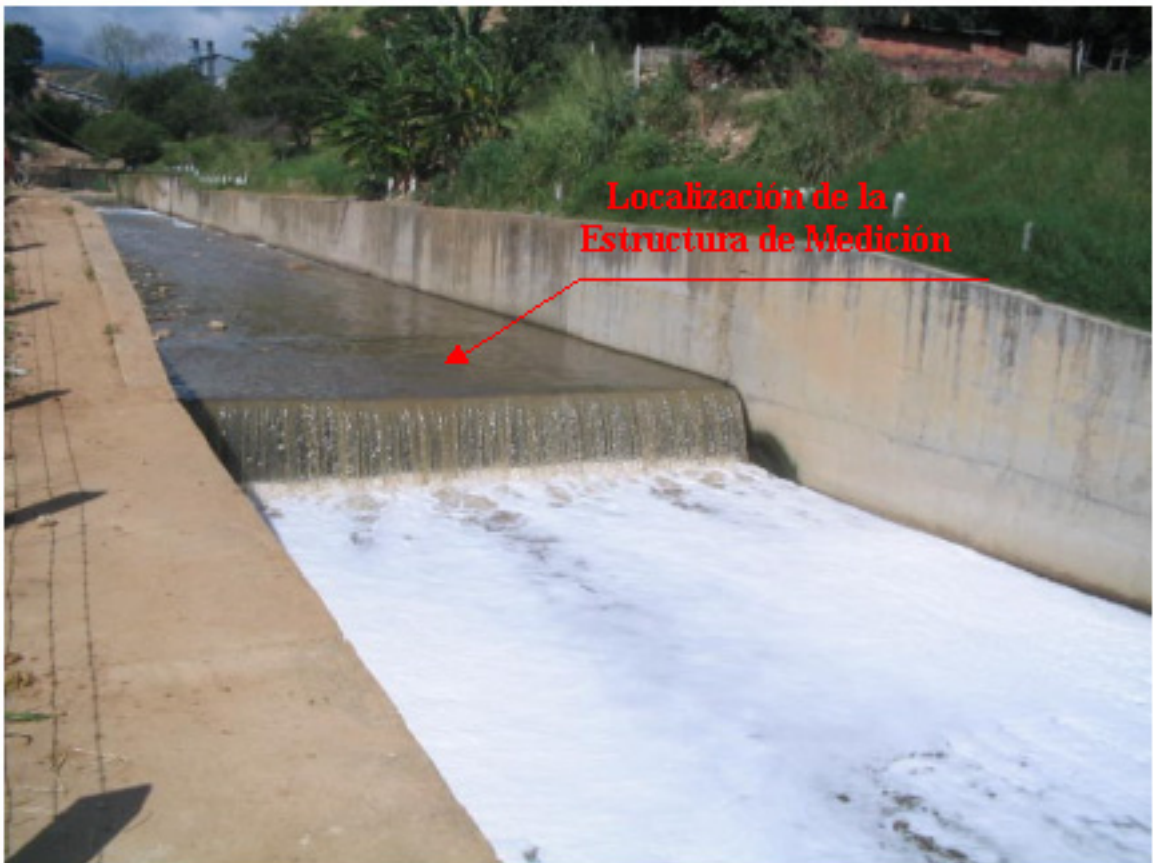
Figura 47. Localización de la Estructura de Medición de Caudales – Quebrada La Iglesia
