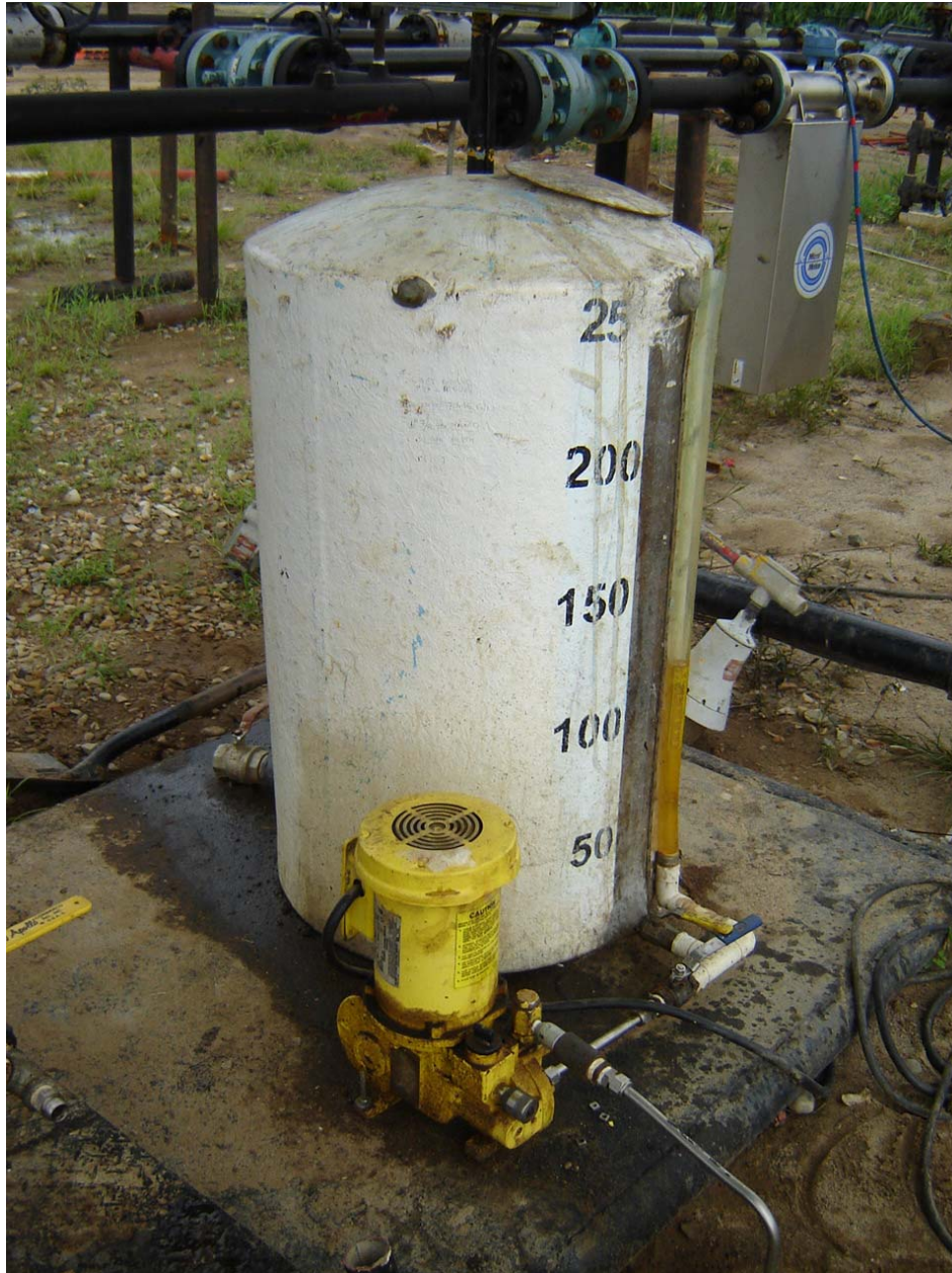
Figura 19. Mecanismo de inyección de desemulsificante.
