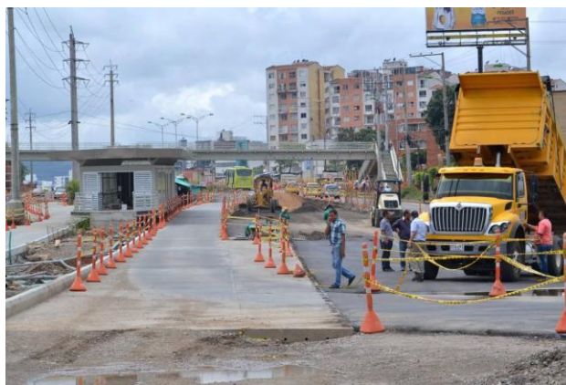
Figura 3. Obras en el tercer carril Bucaramanga – Floridablanca.
