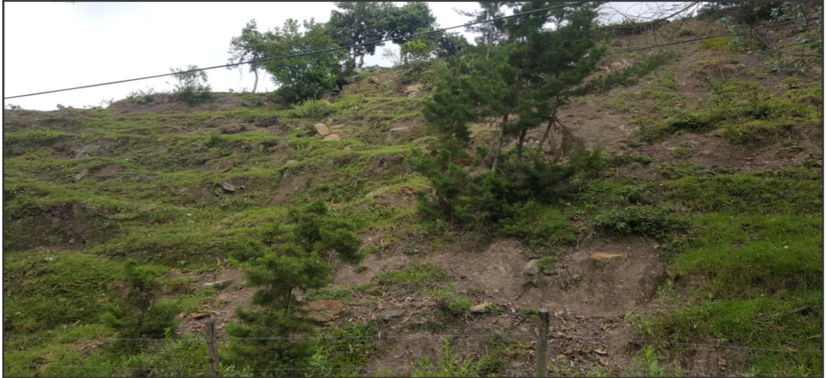
Figura 49. Reptación de suelos, observada al margen izquierdo la vía San Miguel – Macaravita, aproximadamente 50 m en línea recta de la escuela rural San Ignacio, vereda San Ignacio, del Municipio de San Miguel. Fotografía tomada en las coordenadas: E: 1.157.629, N: 1.215.156, en dirección S74°E.
