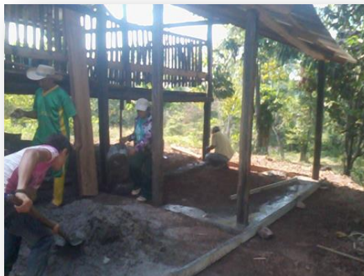
Imagen 11. Construcción de bodega
