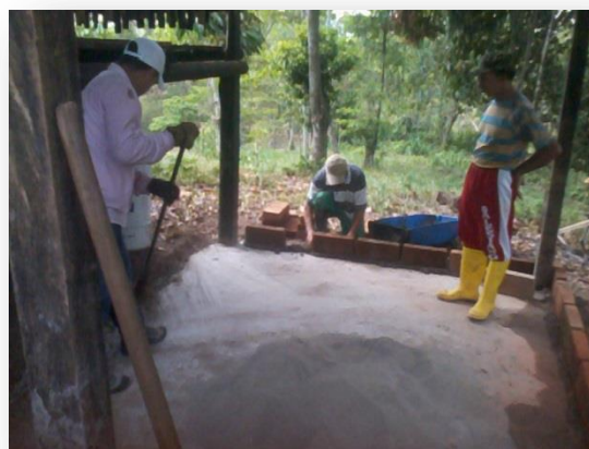
Imagen 12. Construcción de bodega
