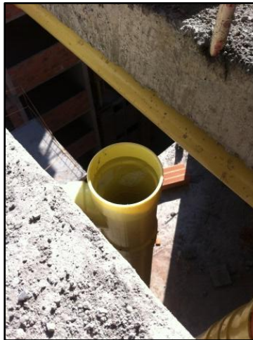
Figura 5. Prueba de estanqueidad T-3 Piso 16 al 19.
