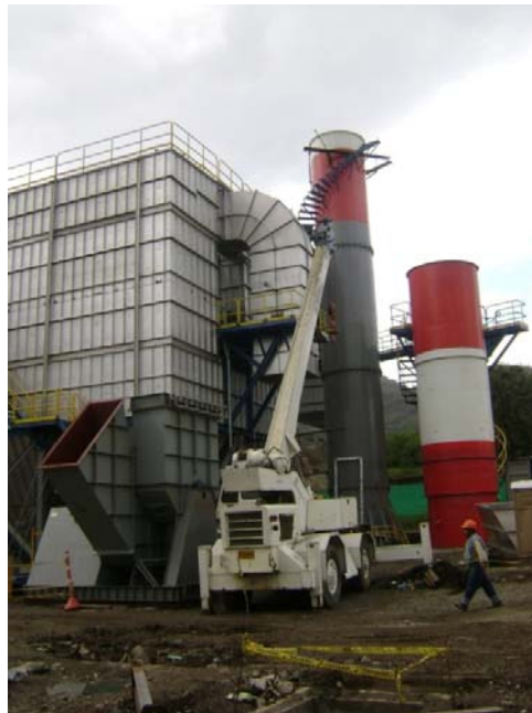
Figura 5. Filtro de mangas Ingemol en proceso de montaje
