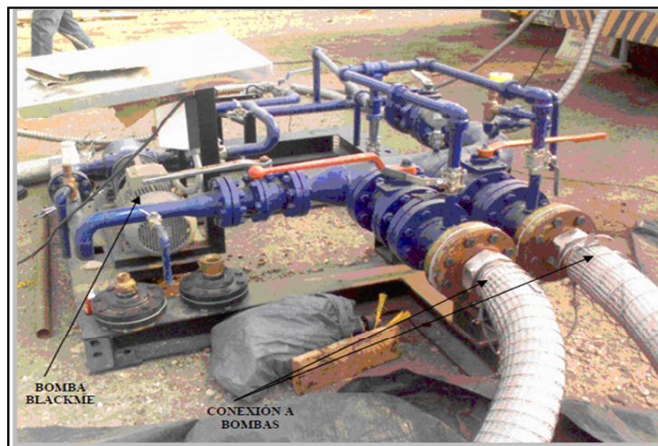
Figura 29. Bomba de la cisterna (Booster)
