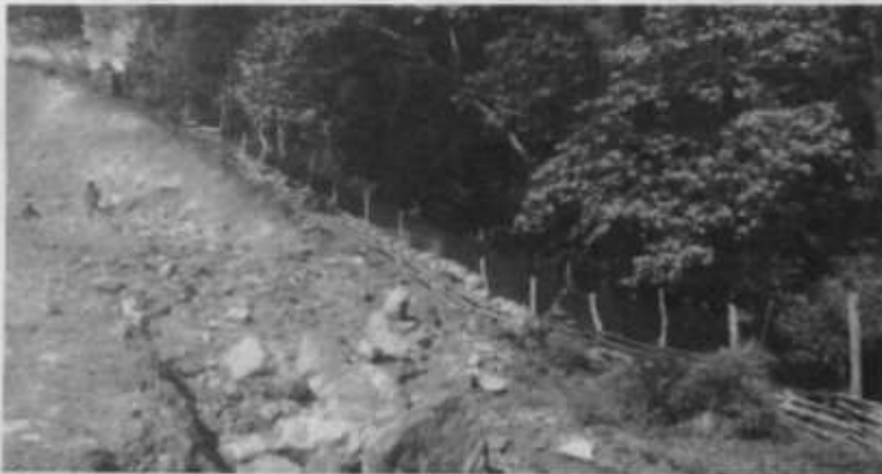
Construcción de trinchos de madera para evitar el material de arrastre y proteger de la acumulacion de estos en los canales naturales
