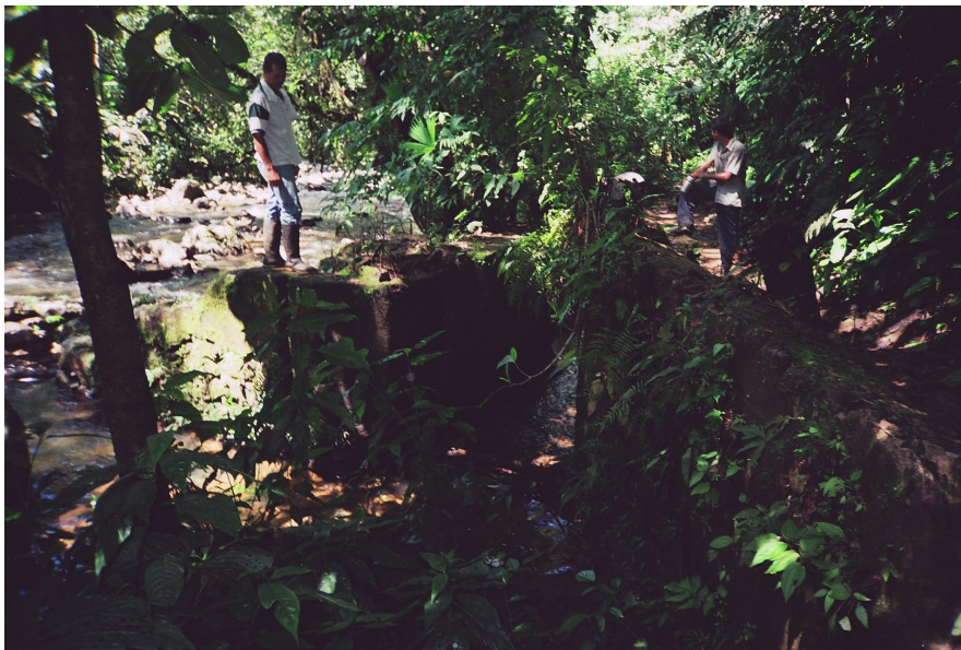
Figura 129: Entrada de la bocatoma y presa parcialmente construidas
