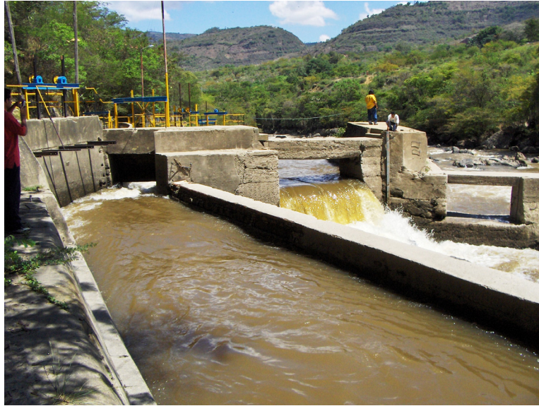
Figura 139: Bocatoma de la central de La Cascada
