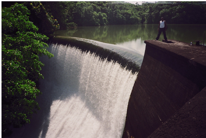
Figura 133: Coronación de la presa y vertedero
