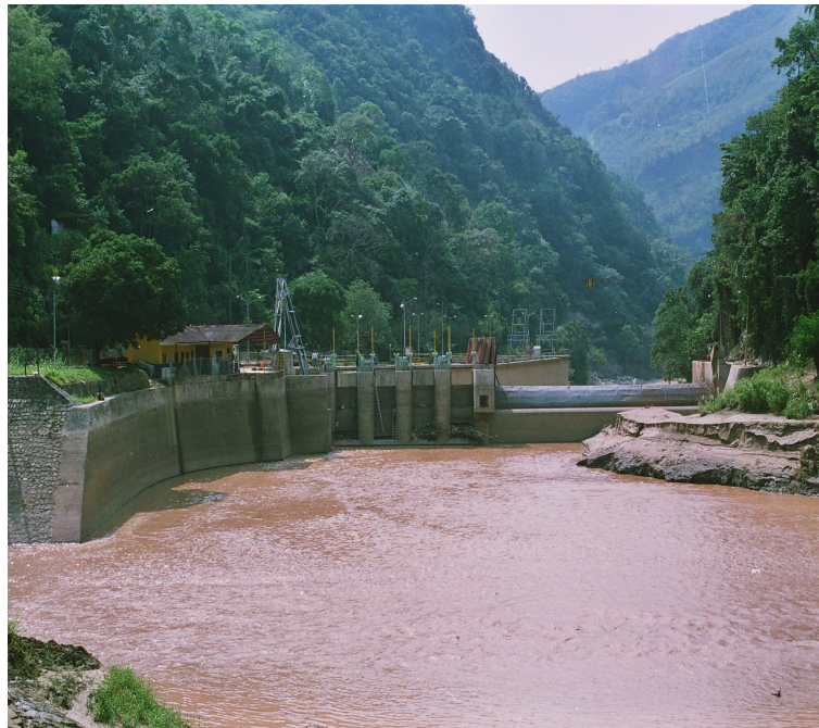
Figura 141: Panorámica de la represa Bocas
