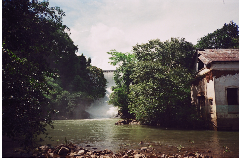
Figura 132: Casa de máquinas y presa
