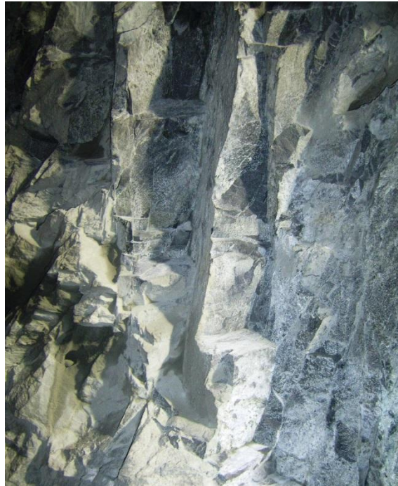
Fotografía 3. Detalle del estado de las discontinuidades en el Túnel de Desviación.
