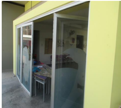
Figura 18. Ventilación e iluminación natural. Portón en vidrio y aluminio con rieles. Centro de Desarrollo Infantil CDI Piedecuesta
