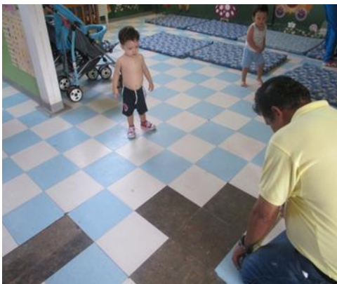
Figura 8. Piso en tableta de vinilo. Salones de Párvulos. Centro de Desarrollo Infantil CDI
