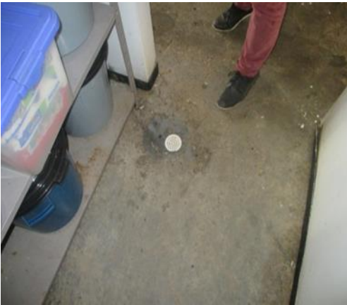
Figura 4. Piso en cemento pulido. Restaurante escolar Centro de Desarrollo Infantil CDI Piedecuesta.
