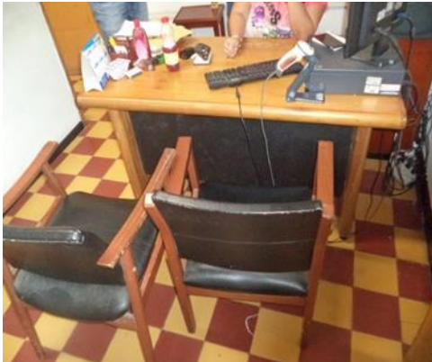
Figura 7. Piso en cerámica. Supermercado CAJASAN Socorro.
