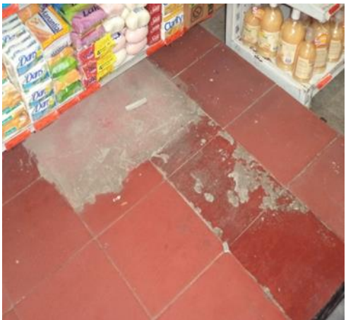
Figura 5. Piso en tableta gres vitrificado liso, Supermercado CAJASAN San Gil
