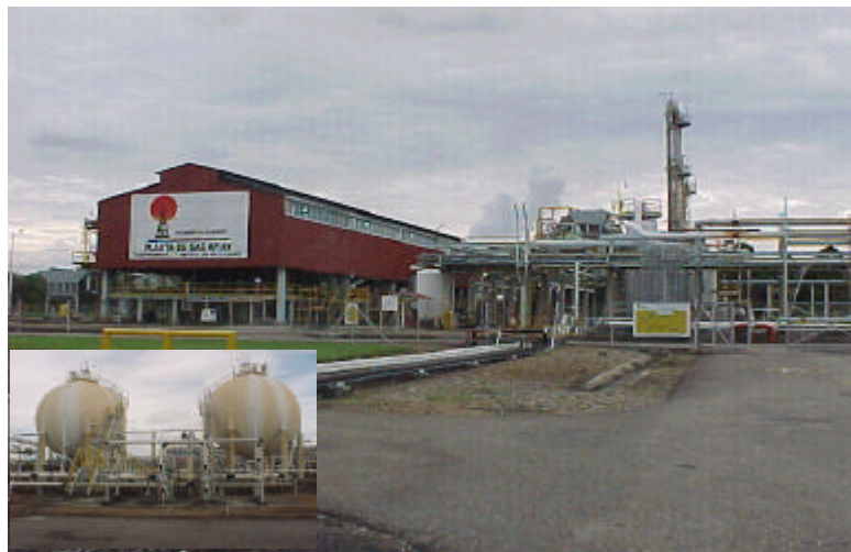
Figura 17. Vista General de la Planta de Gas y Esferas de Almacenamiento de Gas
