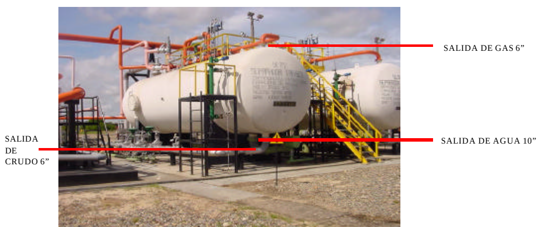
Figura 26. Separador trifásico
