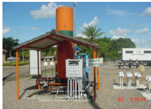
Figuro 29. Equipos Para Aire De Instrumentos
