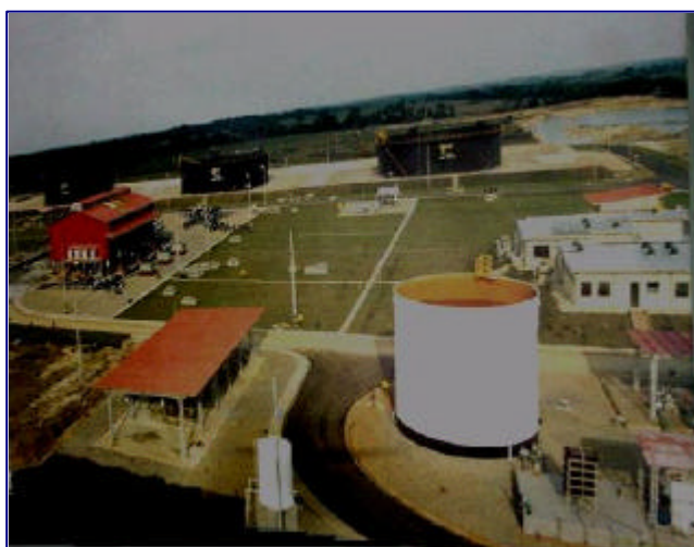
Figura 21 Estación De Bombeo Apiay
