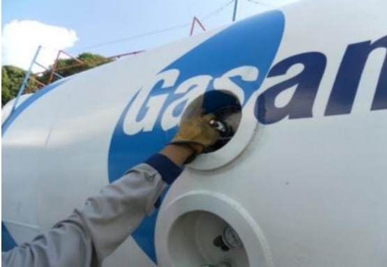
Figura 3. Rotogage en fase de vapor
