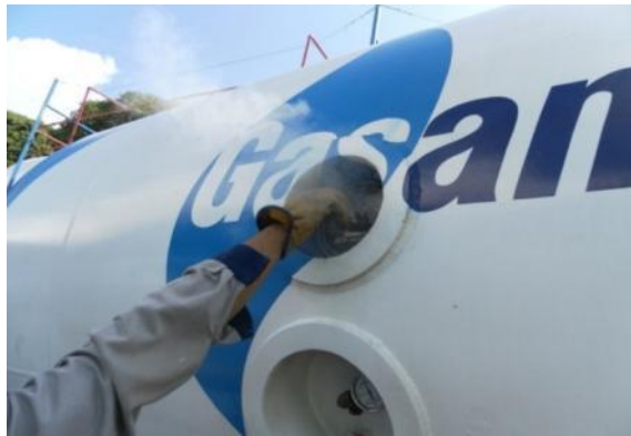
Figura 4. Rotogage en fase líquida
