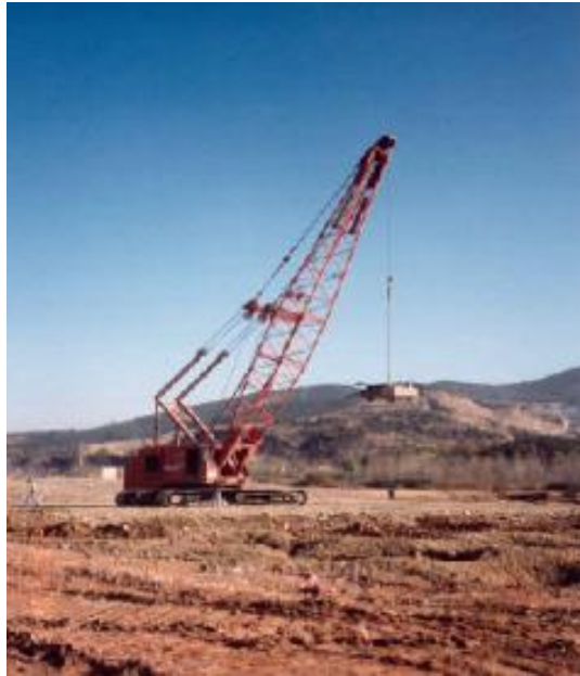
Fotografía 6- 7 Compactación dinámica
