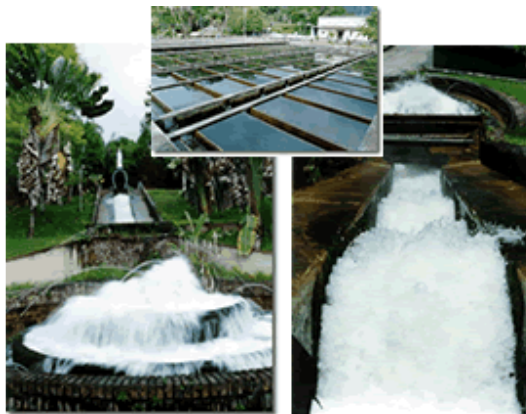
Figura 4. Vista de la Planta de Tratamiento de la Flora
