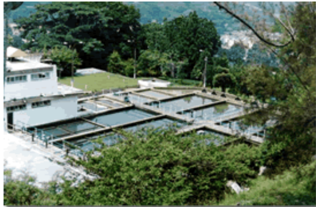
Figura 6. Vista de la Planta de Tratamiento de Floridablanca
