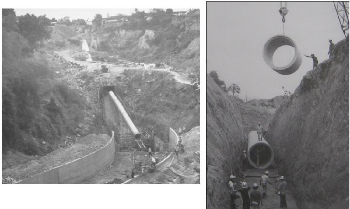
Foto 11. Construcción de los tubos matrices Quebrada la Rosita y El Loro, comienzos del 1970
