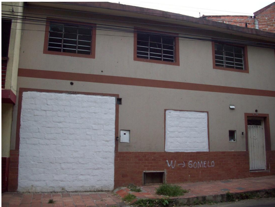
Fotografía 10: Vivienda de bloque de cemento y ladrillo
