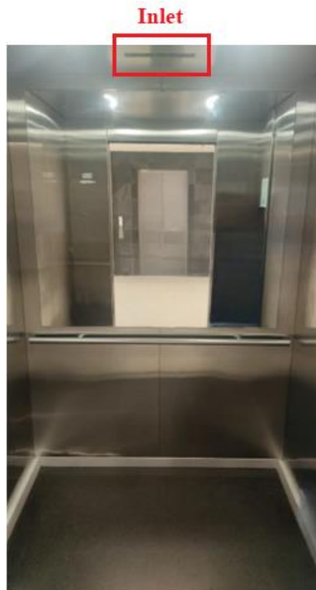
Figura 2 Ubicación de las Rejillas de ventilación
