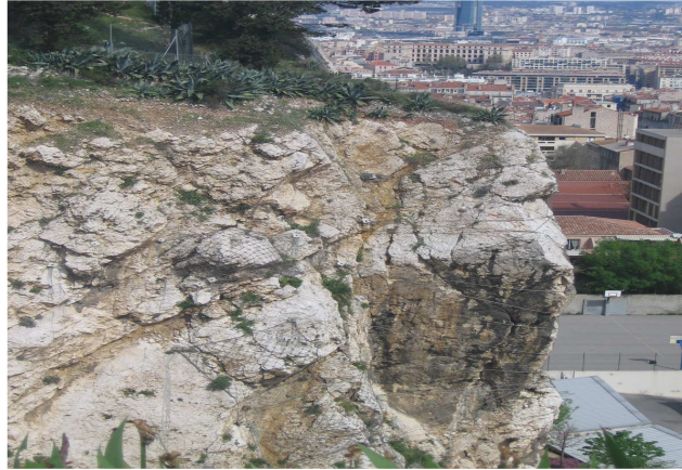
Foto 9: malla de acero. Marsella; Francia.
