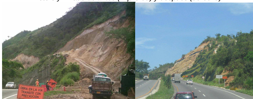
Foto 3 y 4: laderas antes (izquierda) y después (derecha).
