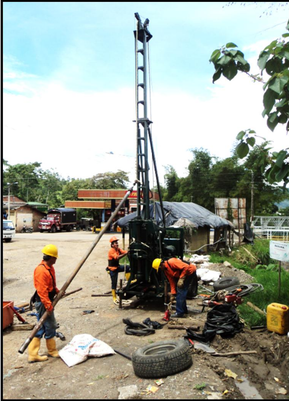
Fotografía N. 3 Detalle Ensayo Rotación
