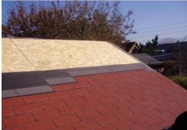
Figura 3.manto de mayor impermeabilización.
