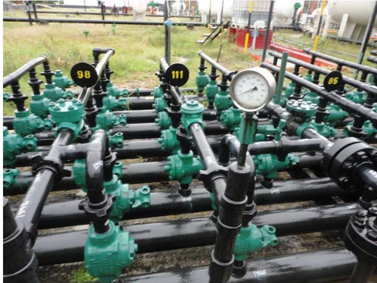
Imagen 2. Sistema típico de LAG en el manifold campo provincia.
