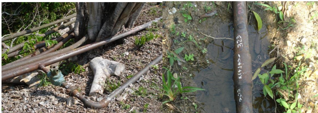
Imagen 10. Fotografías línea de inyección de diámetro 2.375” roscada.
