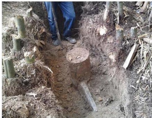
Imagen 7. Válvulas de corte sin identificar.
