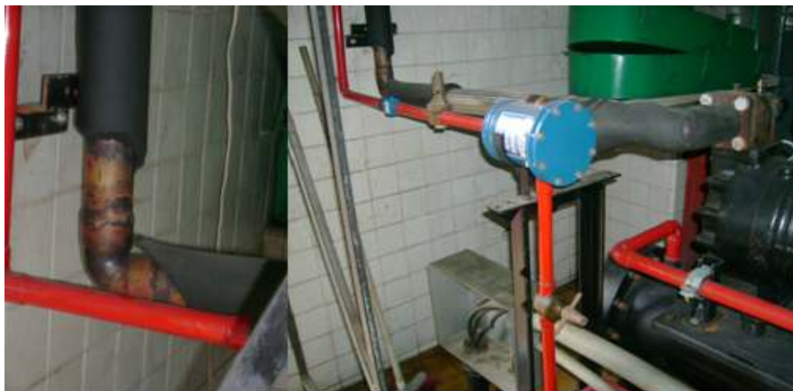
Figura 63. Estado del aislamiento en la tubería de succión
