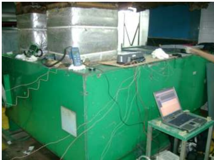
Figura 42. Disposición de los equipos para la toma de datos
