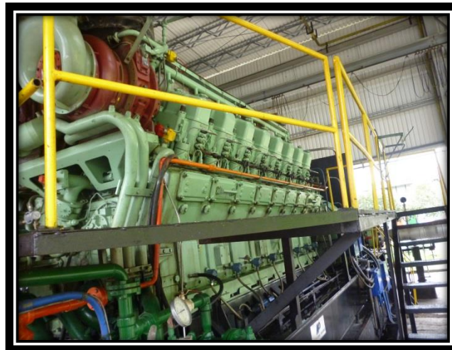
Figura 25. Unidad de Bombeo 106. Costado Derecho
