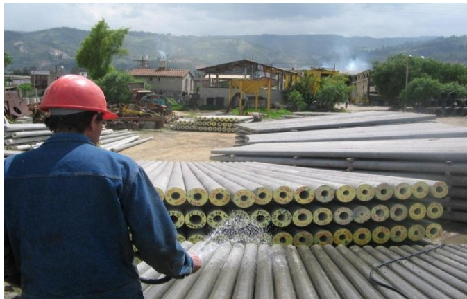
Imagen 13. Riego fraguado final del poste.
