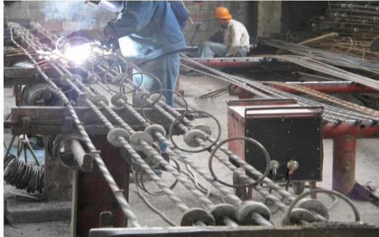
Imagen 5. Soldadura de varillas y aros de armado.
