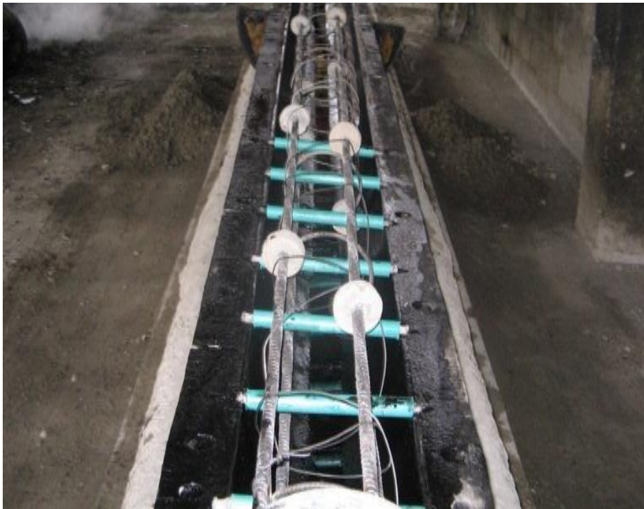
Imagen 8. Colocación de armadura, plaqueta y pasadores.
