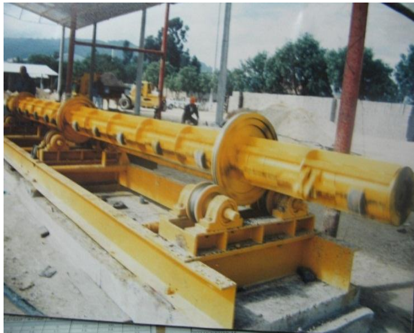
Imagen 11. Centrifugado del poste.
