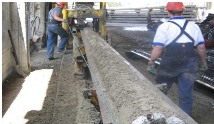
Imagen 10. Compactación y moldeo del poste.
