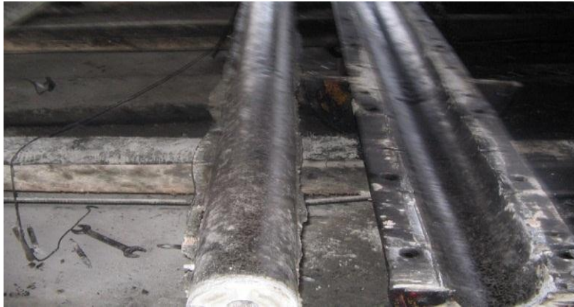
Imagen 12. Desencofre y perfil del poste.
