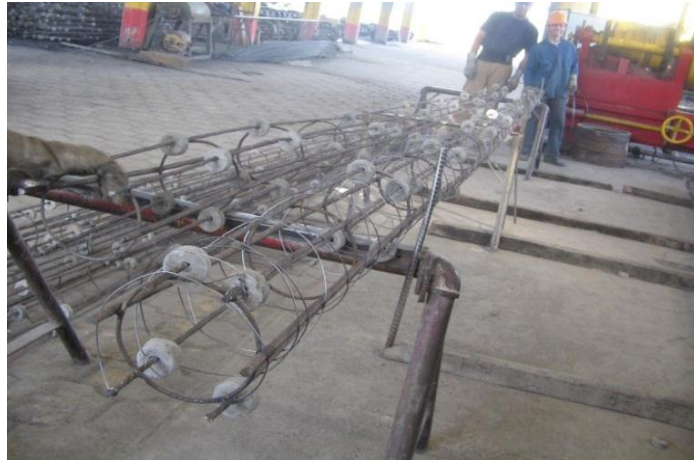
Imagen 6. Colocación de alambre y almacenamiento.
