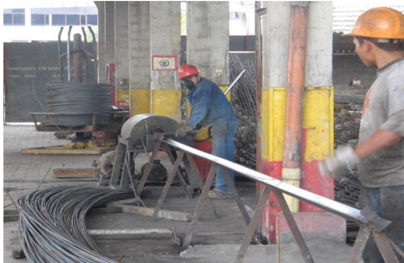
Imagen 2. Estirar y cortar varillas.
