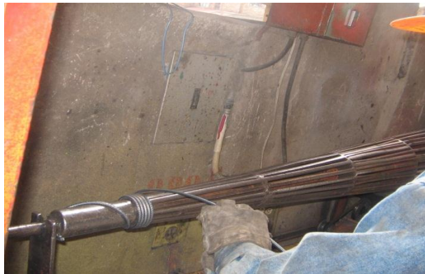
Imagen 1. Fabricación de aros de armado.
