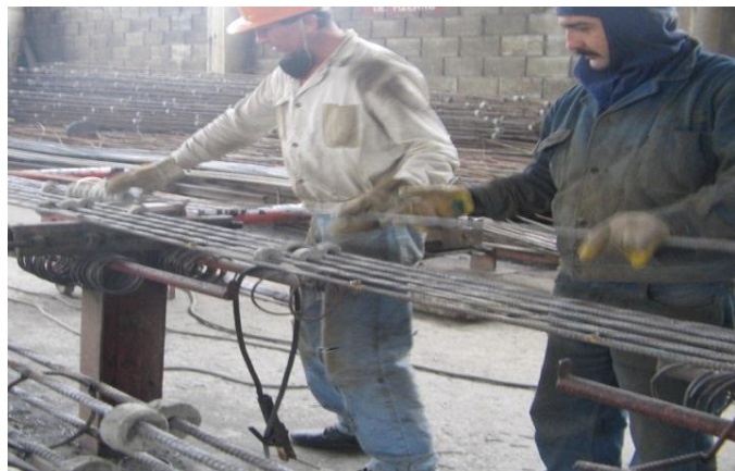
Imagen 4. Colocación de separadores
