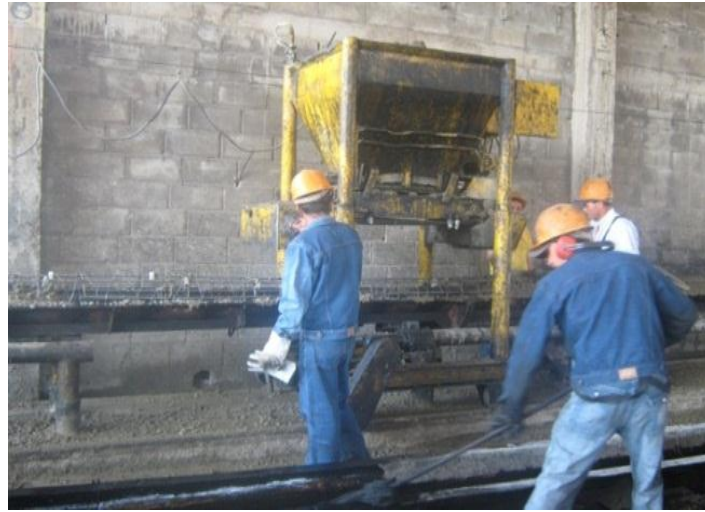
Imagen 9. Vaciado de la mezcla en la formaleta.
