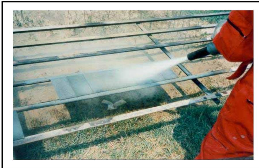
***Figura 35. Preparación de superficie de acero al carbono 1020 con sand-blasting.***
