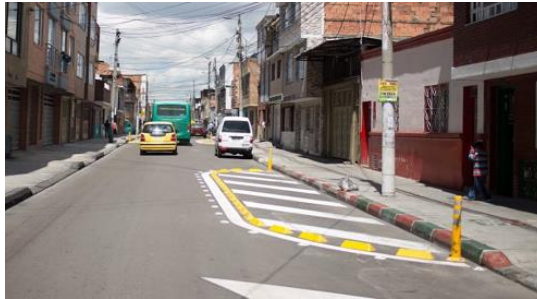
Figura 7. Reducción de carril con pintura en Bogotá.
