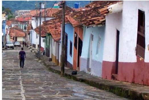
Figura 4. Pavimento en roca, calle 13, Socorro.
