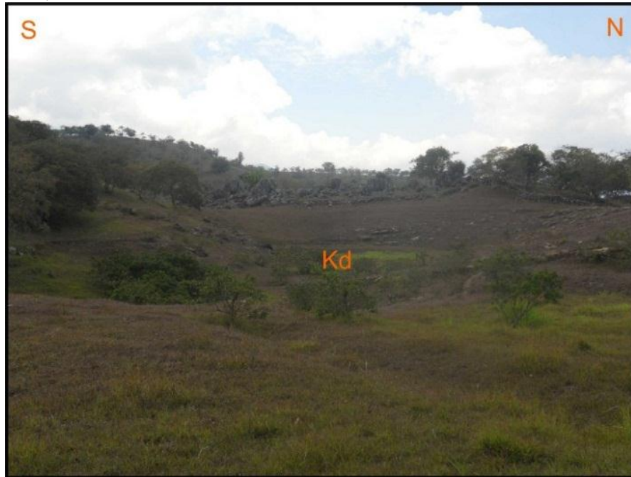
Figura 61. Panorámica de la Finca La Joya – vereda Las Flores en el municipio de Zapatoca, mostrando una dolinas.
