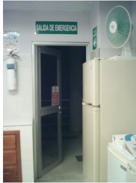
Foto 8: salida de emergencia y señalización de la ruta de evacuación
