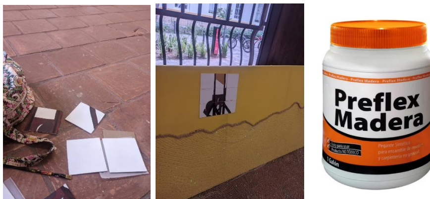
Figura 45. Proceso 2, Proceso de montaje y materiales
