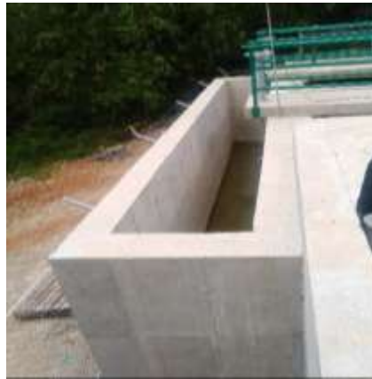
Figura 12. Canal de igualación miniptar La liga.
