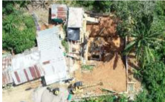
Figura 26. Vista superior del estado de obra Villarosa.
