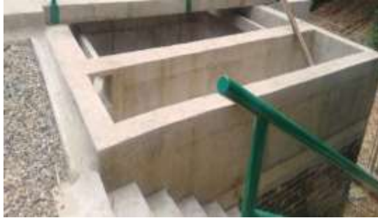
Figura 16. Vertedero miniptar La liga.
