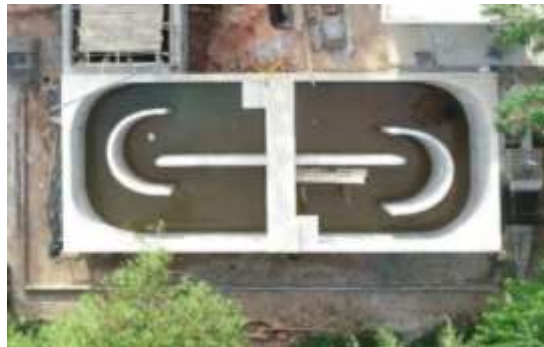
Figura 11. Zanjón de Oxidación miniptar La liga.
