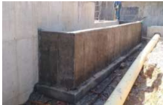
Figura 13. Canal de igualación miniptar Villarosa.
