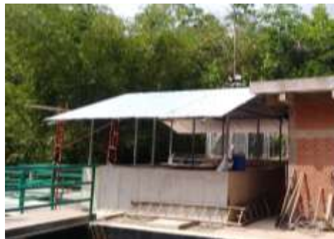
Figura 20. Lechos de secado miniptar La liga.
