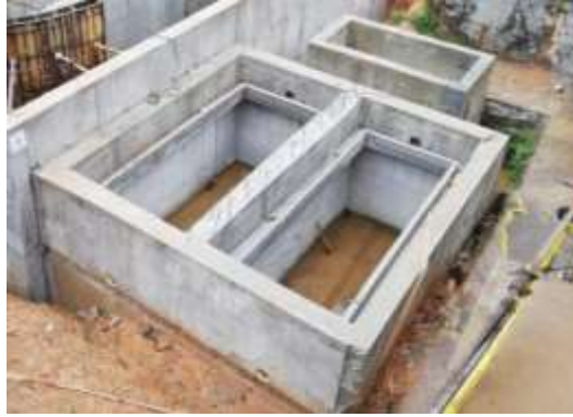
Figura 14. Sedimentadores miniptar Villarosa.
