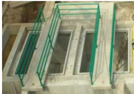
Figura 15. Sedimentadores miniptar La liga.
