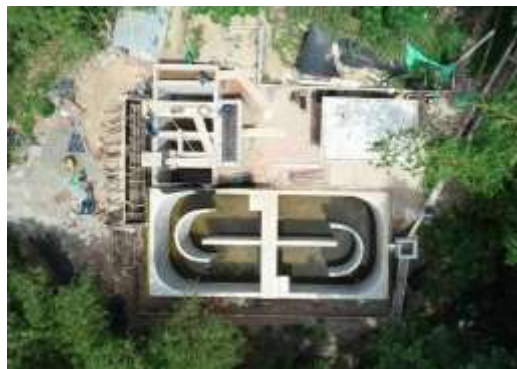
Figura 25. Vista superior de estado de obra la liga.
