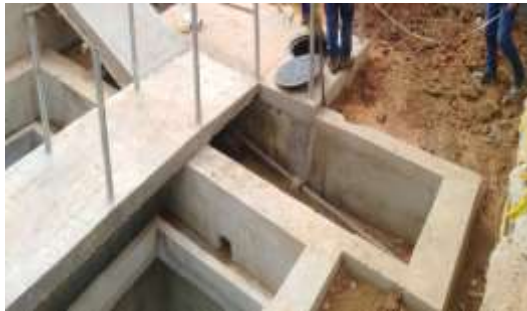
Figura 17. Vertedero miniptar Villarosa
