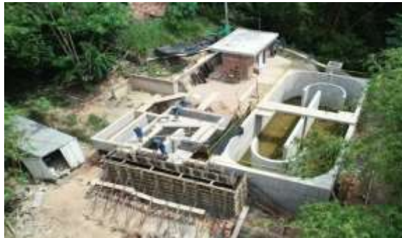
Figura 24. Vista lateral de estado de obra la liga.
