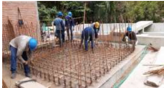
Figura 29. Supervisión de obra - Miniptar La Liga.
