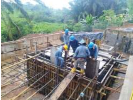
Figura 28. Supervisión de obra - Miniptar Villarosa.
