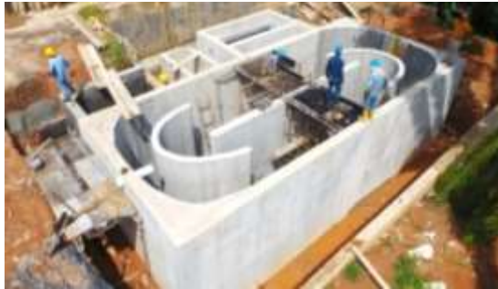
Figura 10. Zanjón de Oxidación miniptar Villarosa.
