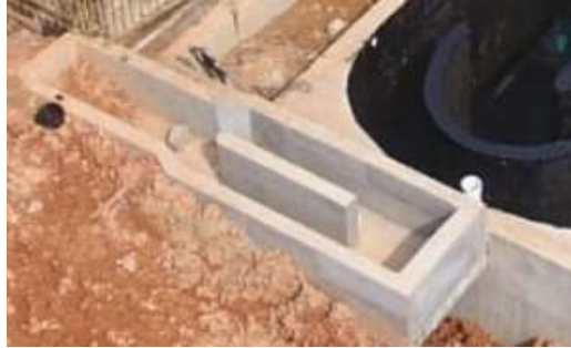
Figura 9. Desarenador miniptar Villarosa
