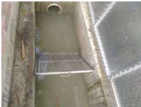
Figura 8. Cribado miniptar La liga.
