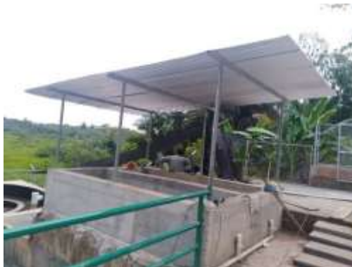
Figura 21. Lechos de secado miniptar Villarosa.
