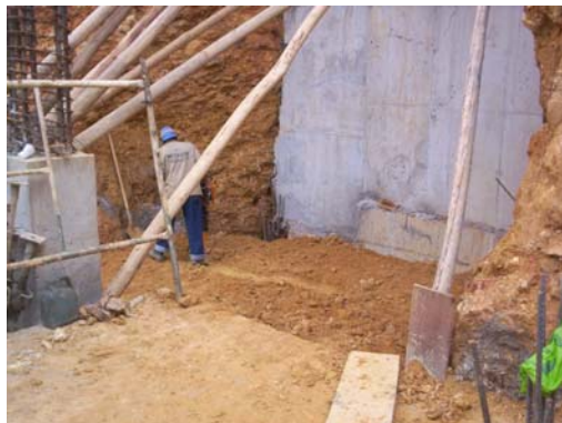
Figura # 10: Proceso de Compactación
