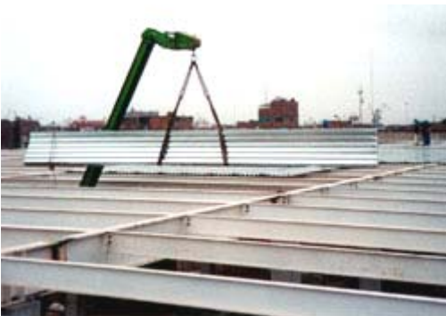
Figura # 60: Manipulación mecánica.
