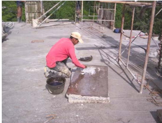
Figura # 16: Preparación de Formaleta.
