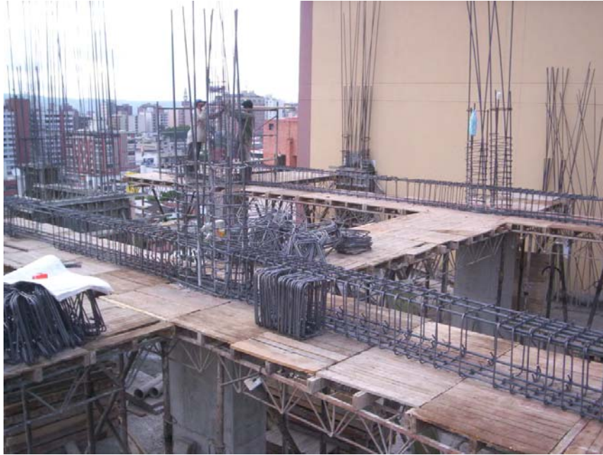
Figura # 48: Vigas ya armadas.
