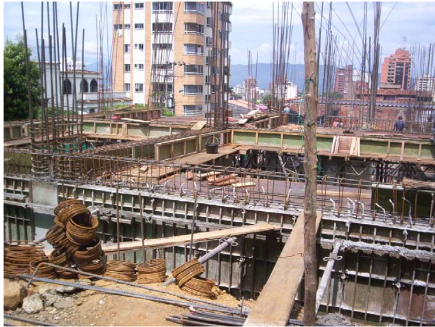
Figura # 51: Retranque Vigas.
