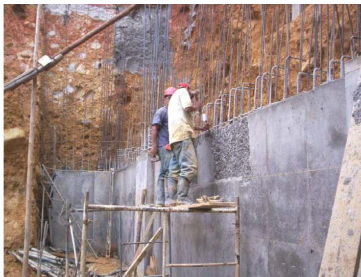
Figura # 26: Reparación de Concreto en Muro de Contención.
