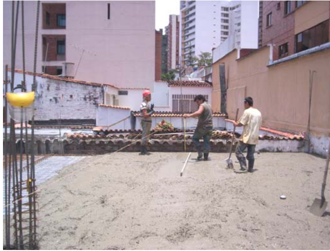
Figura # 94: Proceso de Fundida de Placas de entrepiso.
