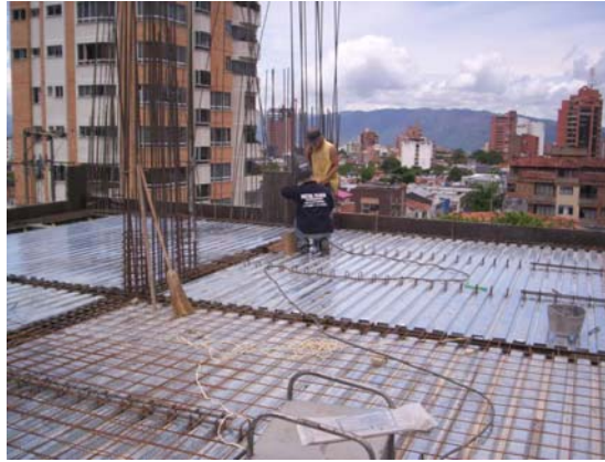
Figura # 75: Proceso de soldadura de Conectores.
