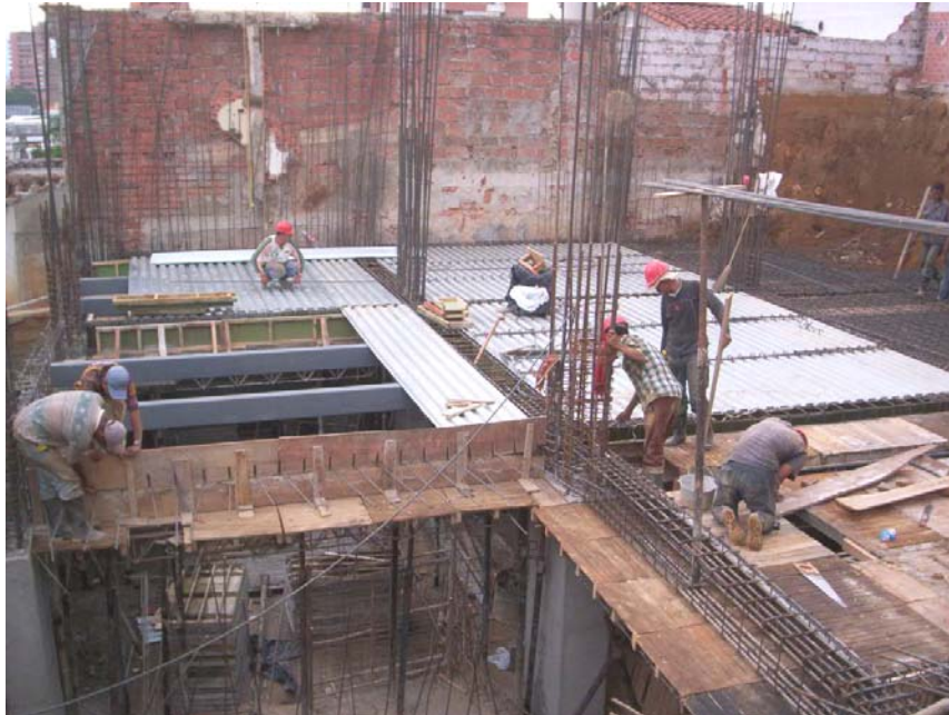
Figura # 67: Apoyo de láminas en los perlines y bandas.
