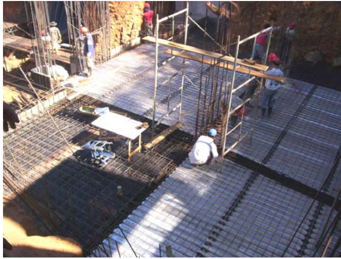
Figura # 85: Vista de la Placa de entepiso lista para fundida.
