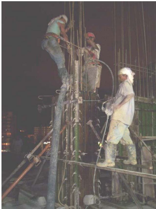
Figura # 21: Vibrado del Concreto.
