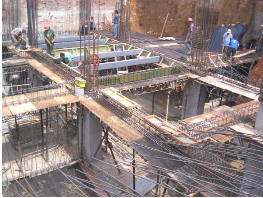
Figura # 55: Colocación Perlines.
