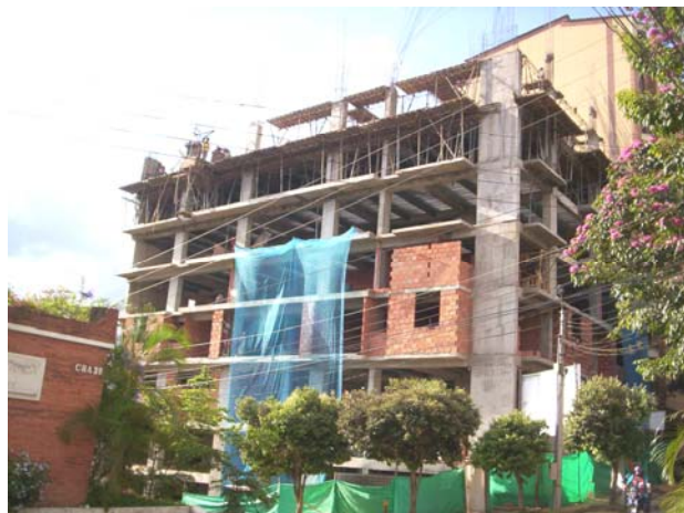
FIGURA # 1: Sistema de pórticos.
