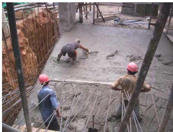
Figura # 24: Acabado a Llana Rampas Parqueaderos.
