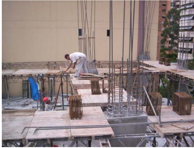
Figura # 44: Amarre de Vigas.
