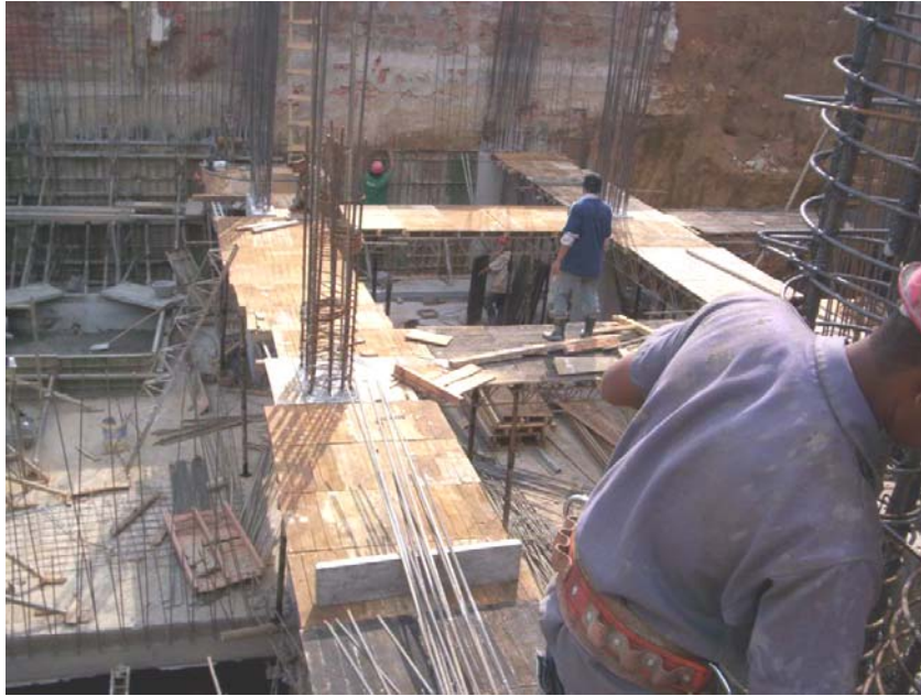
Figura # 40: Estos Tableros se amarran entre si con Alambre Negro N° 18.
