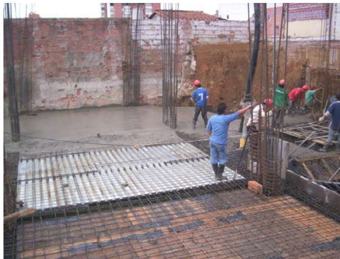
Figura # 90: Proceso de Fundida de Placa de Entrepiso.
