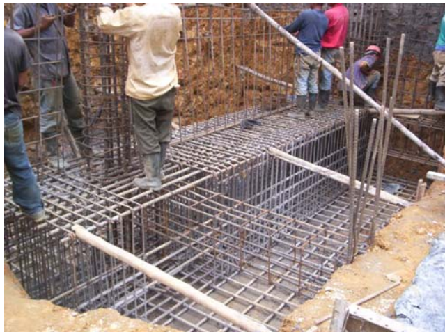
FIGURA # 7: Cimientos en Concreto.
