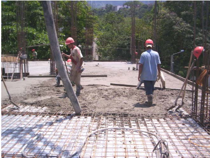
Figura # 95: Fundida Placa de entrepiso.
