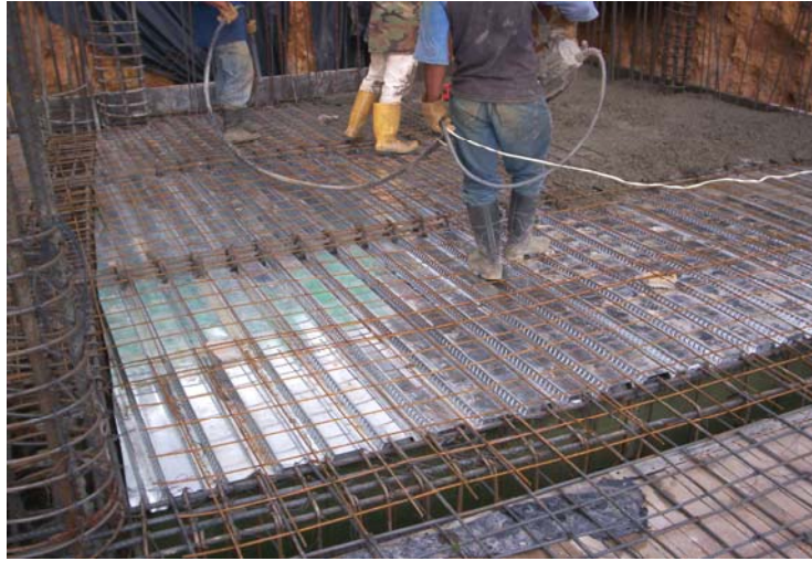
Figura # 91: Vaciado y Vibrado del Concreto.
