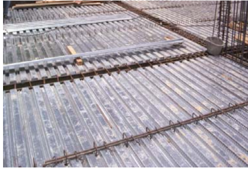
Figura # 74: Instalación de Conectores en la Placa.
