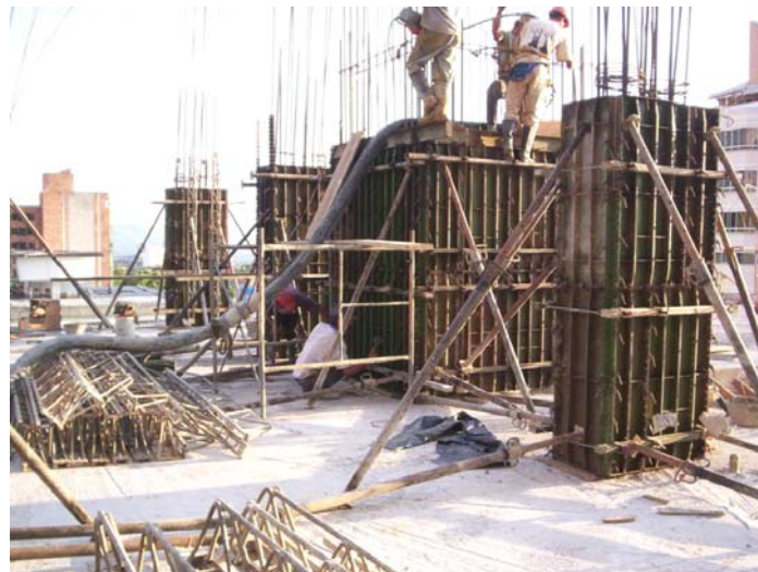
FIGURA # 3: Foso Ascensor.
