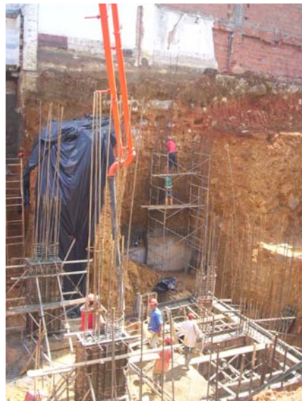
Figura # 19: Vaciado Concreto Columnas (Bomba).
