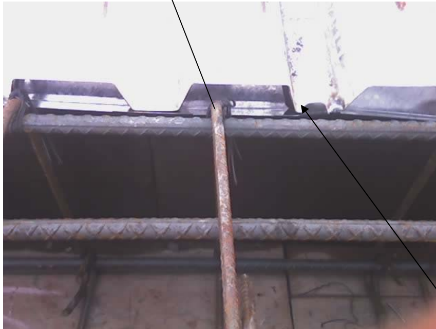
Figura # 73: Detalle Testero (Soldadura E-6013).
