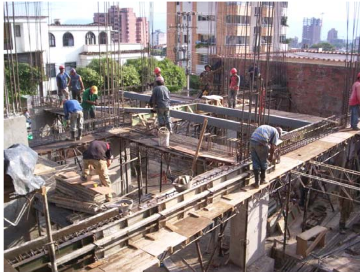
Figura # 56: Colocación de Perlines en su sitio para su posterior ensamble.
