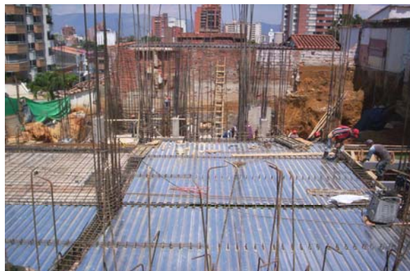
Figura # 76: Conectores separados cada 15cm en Áreas de Parquaderos.
