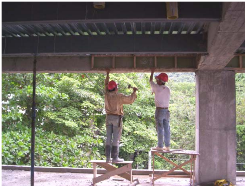
Figura # 22: Desformaleteo de Vigas en placa de entepiso.
