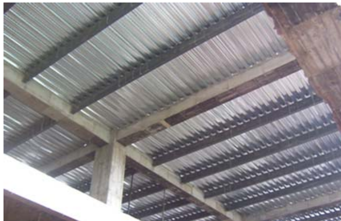
Figura # 97: Acabado Bajo Placa.
