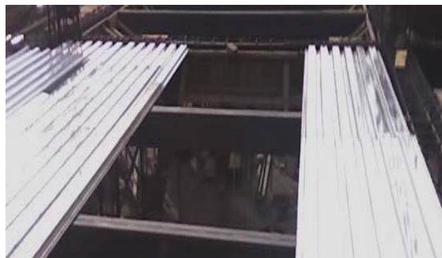
Figura # 66: Apoyo sobre Los Perlines.
