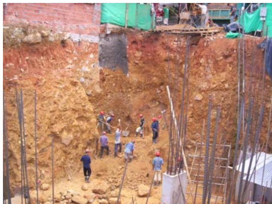
Figura # 12: Excavaciones y Retiro Material.
