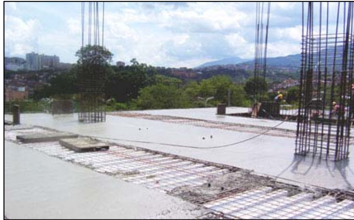
Figura # 96: Fundida Placa.
