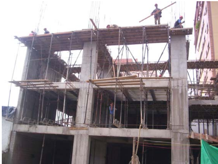
Figura # 43: Proceso Entablarado Vigas.
