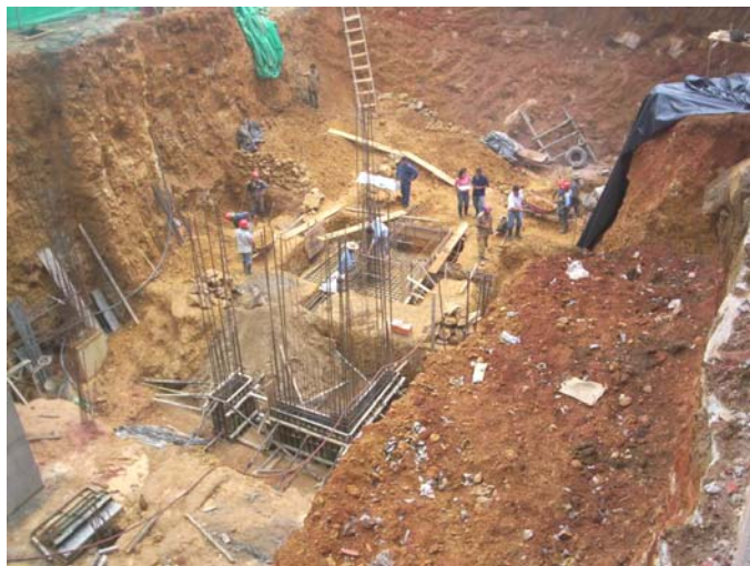
FIGURA # 6: Vista Aérea Cimentación edificio.
