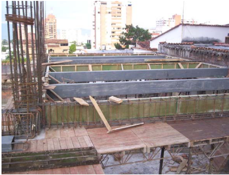
Figura # 59: Instalación Perlínes.
