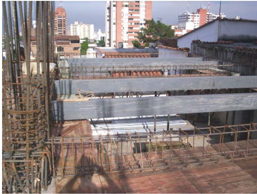
Figura 57: Perlins en Vigas Principales.
