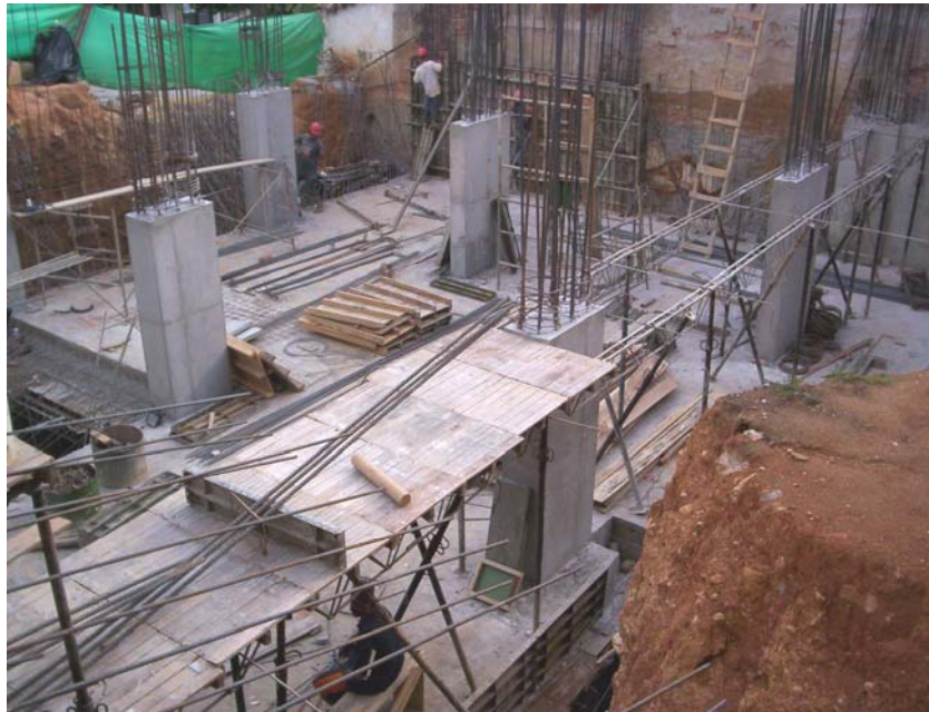
Figura # 39: Las Dimensiones de los Tableros de madera son 0.70mx1.40m.
