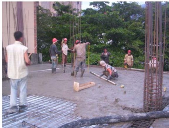
Figura # 23: Acabado a Regla en Placas de Entrepiso.
