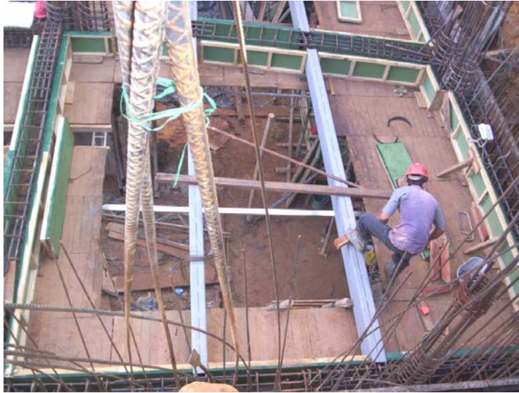
Figura # 53: Instalación de Perlines.
