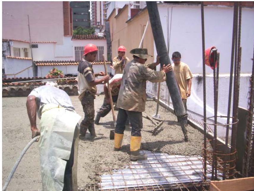
Figura # 92: Vaciado de Concreto.
