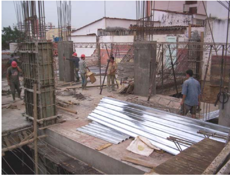
Figura # 38: Las cerchas utilizadas son de 3m y los párales (Tacos metálicos) son de 3.20m y 3.60m.
