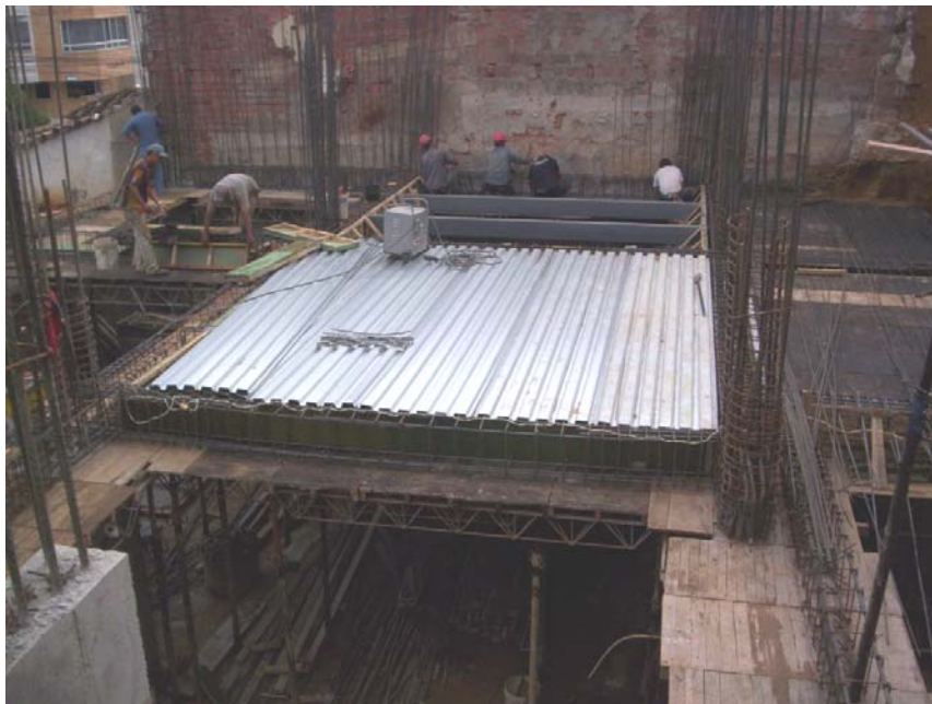
Figura # 68: Distribución de Corpalosas.
