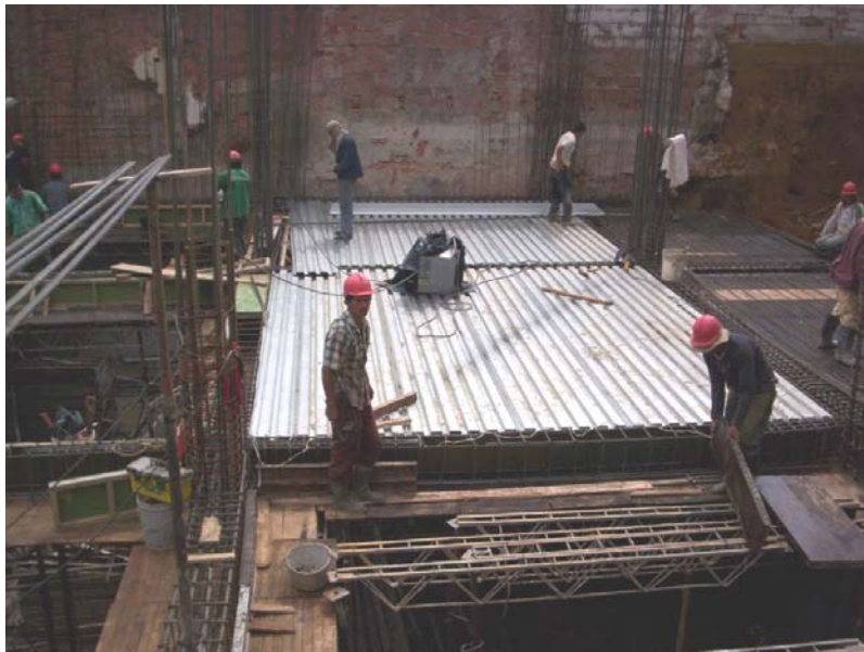
Figura # 71: Soldada y traslazo de Corpalosas.
