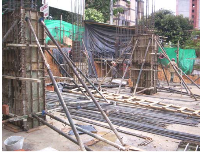
Figura # 18: Formaleta Columnas.
