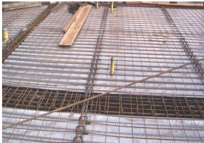
Figura # 78: Pases sanitarios y malla estructural.
