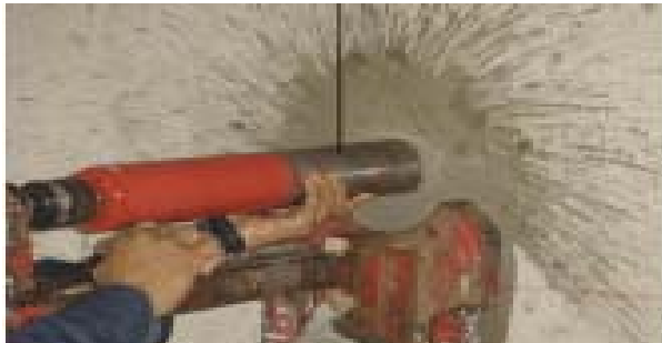
Figura # 102: Extracción de Núcleo.
