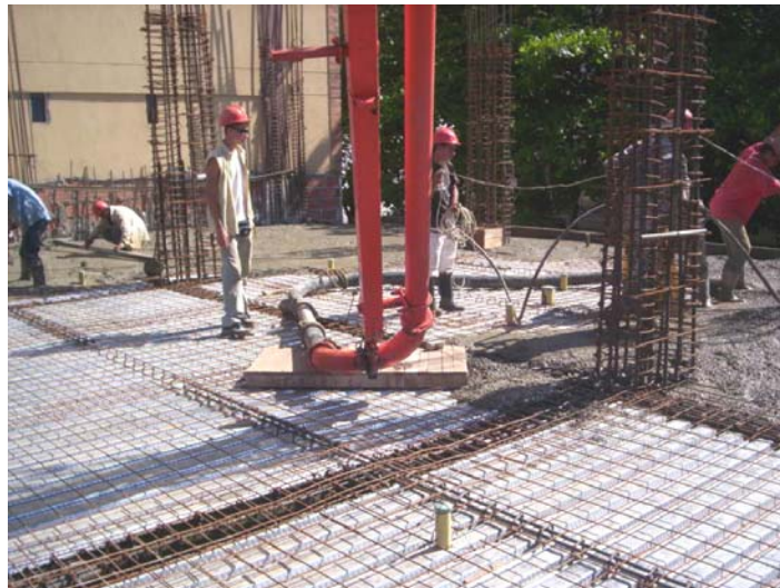
Figura # 93: Fundida de Placa con la AutoBomba.
