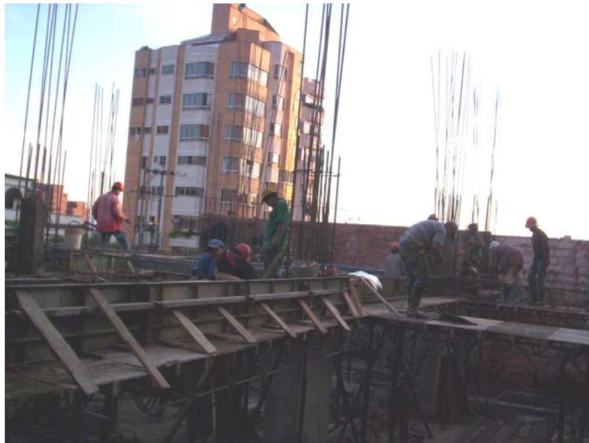
Figura # 52: Formaleteo de Vigas con Tableros Metálicos.
