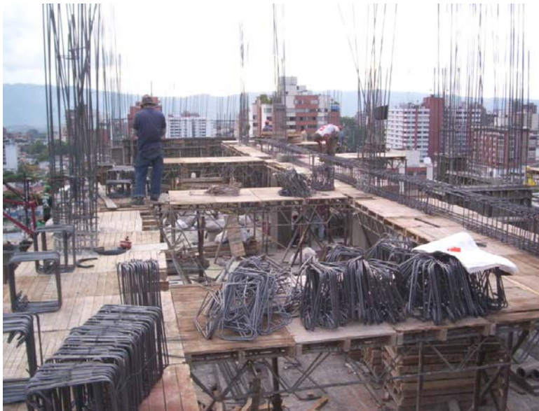
Figura # 45: Distribución de Estribos (Flejes).
