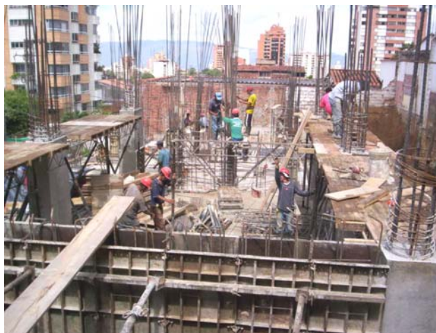
Figura # 17: Armada Formaleta Muro de Contención.
