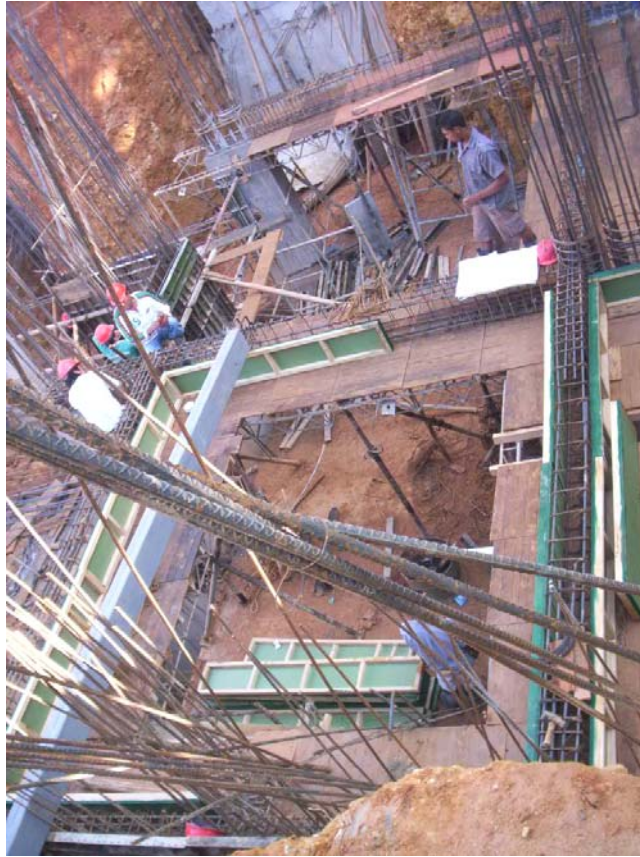
Figura # 49: Formaleteo de Vigas con Bandas de Madera.
