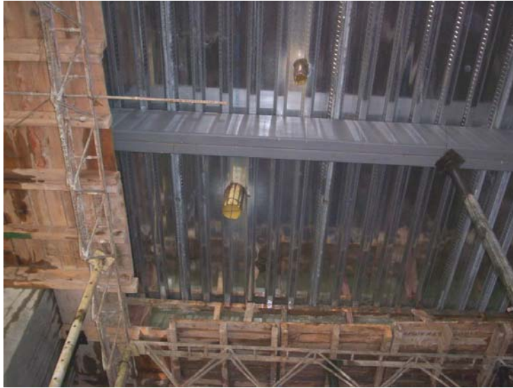
Figura # 89: Retranque de Placa Bajo Viguetas Metálicas.
