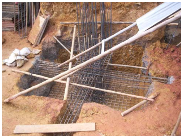
Figura # 9: Vigas de Amarre.
