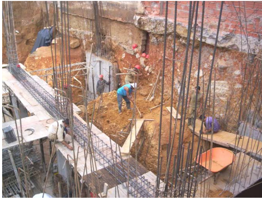
Figura # 46: Amarre del herraje de las Vigas.
