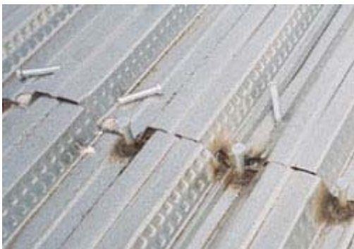
Figura # 69: Fijación Lámina Colaborante.
