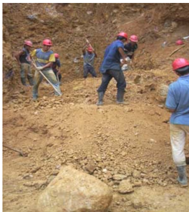
FIGURA # 4: Excavación manual.
