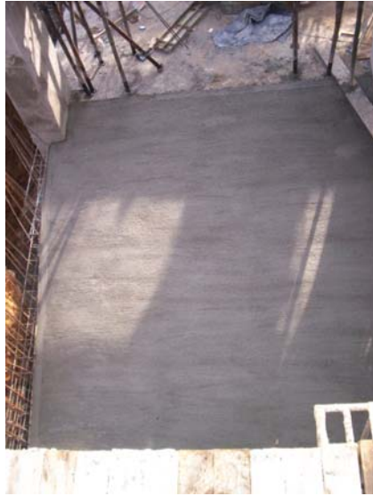
Figura # 25: Acabado final rampa parqueadero
