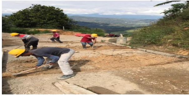
Figura 8. Excavación manual de material común y conglomerado.
