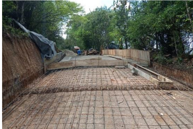
Figura 11. Actividad .Instalación Acero de Refuerzo.
