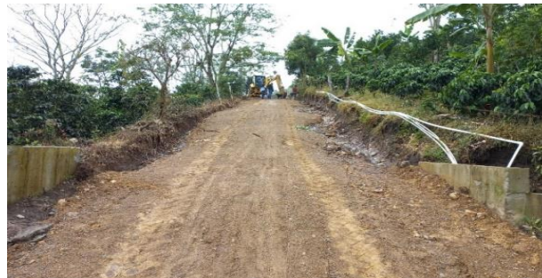
Figura 7. Conformación de la calzada existente con maquinaria amarilla.
