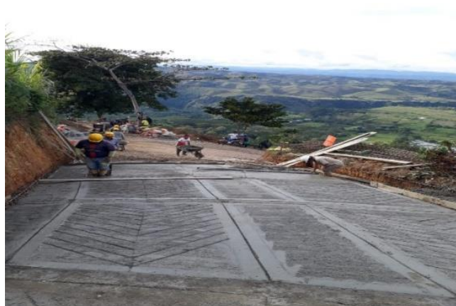
Figura 9. Fundición de concreto con resistencia a la compresión
