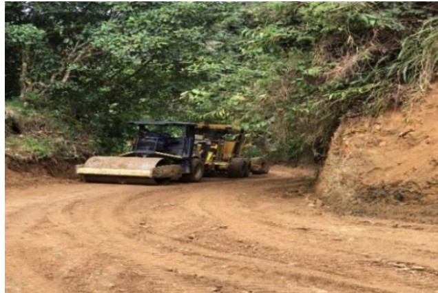
Figura 5. Instalación Subbase granular, municipio de La Plata – El Bosque Tramo II.
