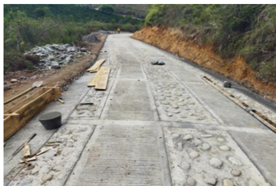
Figura 10. Concreto Ciclópeo
