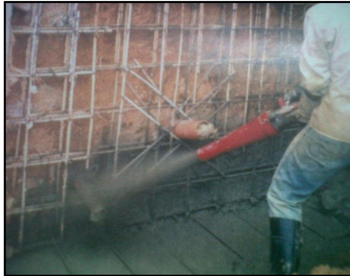
Figura 21 - Aplicación del concreto proyectado vía húmeda
