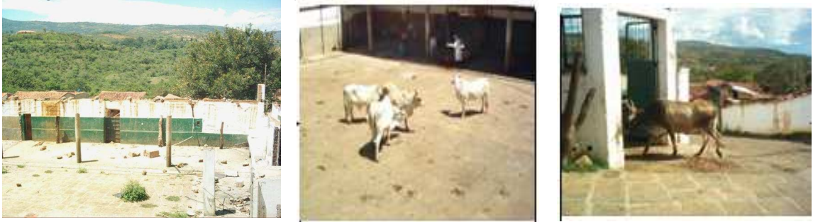
Fotografía 3. Deterioro de pisos y paredes
