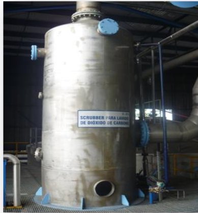
Figura 3. Columna de absorción INCAUCA S.A.
