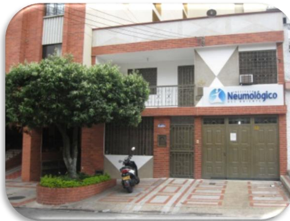
Figura 4. Instalaciones INO S.A. El Prado
