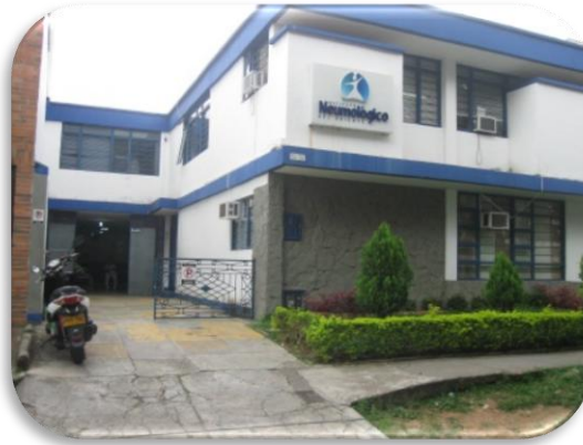
Figura 3. Instalaciones INO S.A. Cabecera
