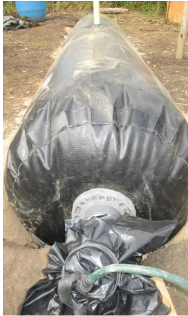
Figura 53. Llenado de la geomembrana con agua
