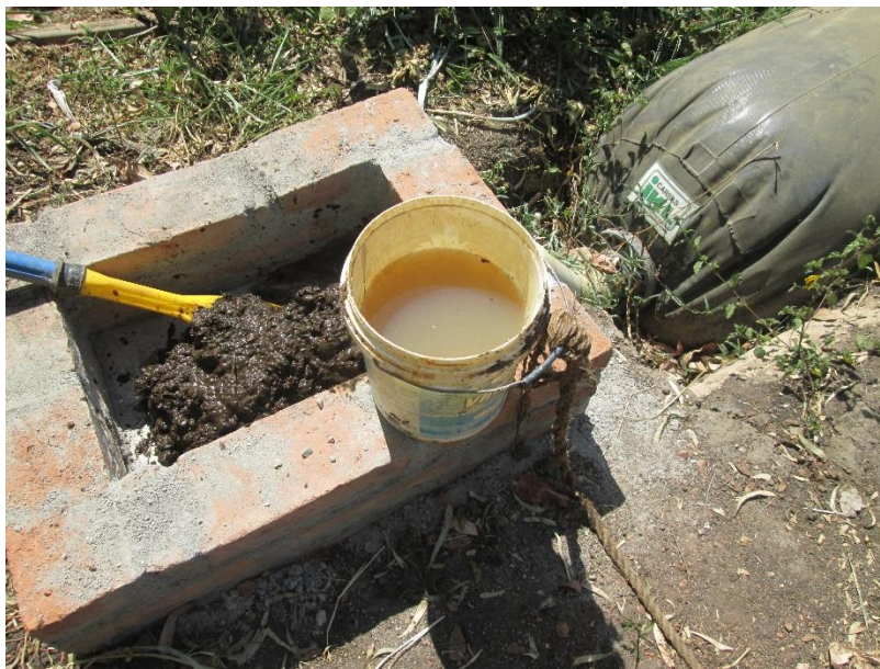
Figura 4. Preparación de material para el biodigestor
