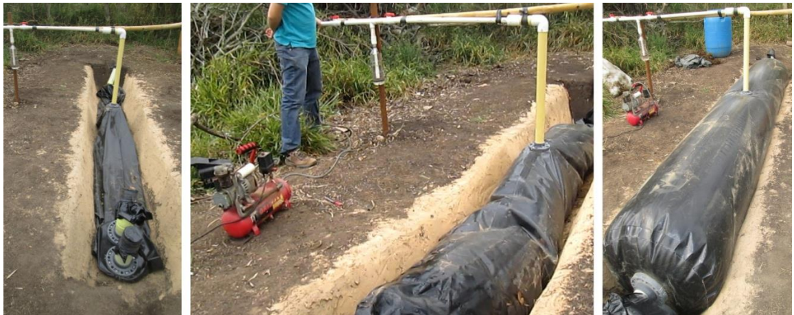
Figura 52. Inflado de la geomembrana
