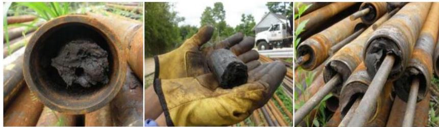
Figura 1. Parafinas depositada en tuberías de producción Campo Colorado. [10]
