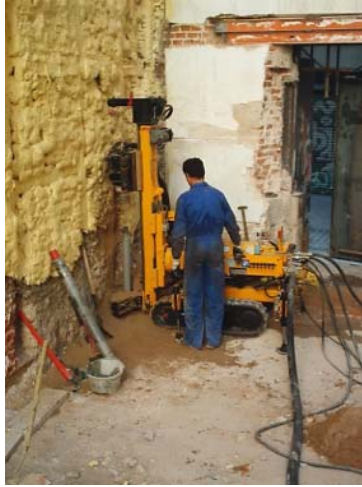
Fotografía 1. Ejemplos de perforadoras propicias para ejecución de micropilotes perforados.
