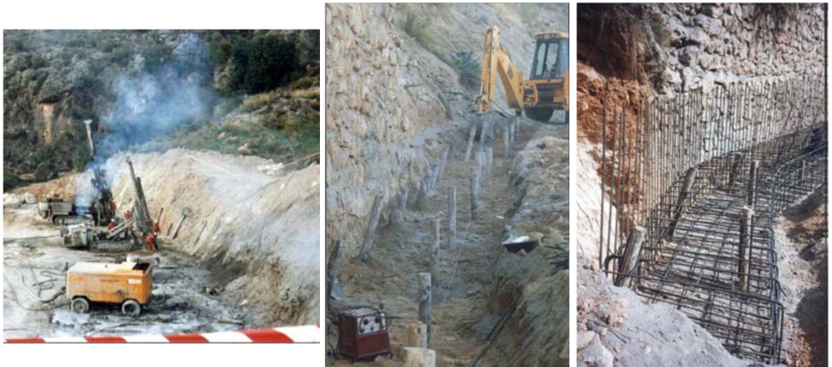
Fotografía 4. Ejemplo de construcción de micropilotes para estabilización de deslizamientos.
