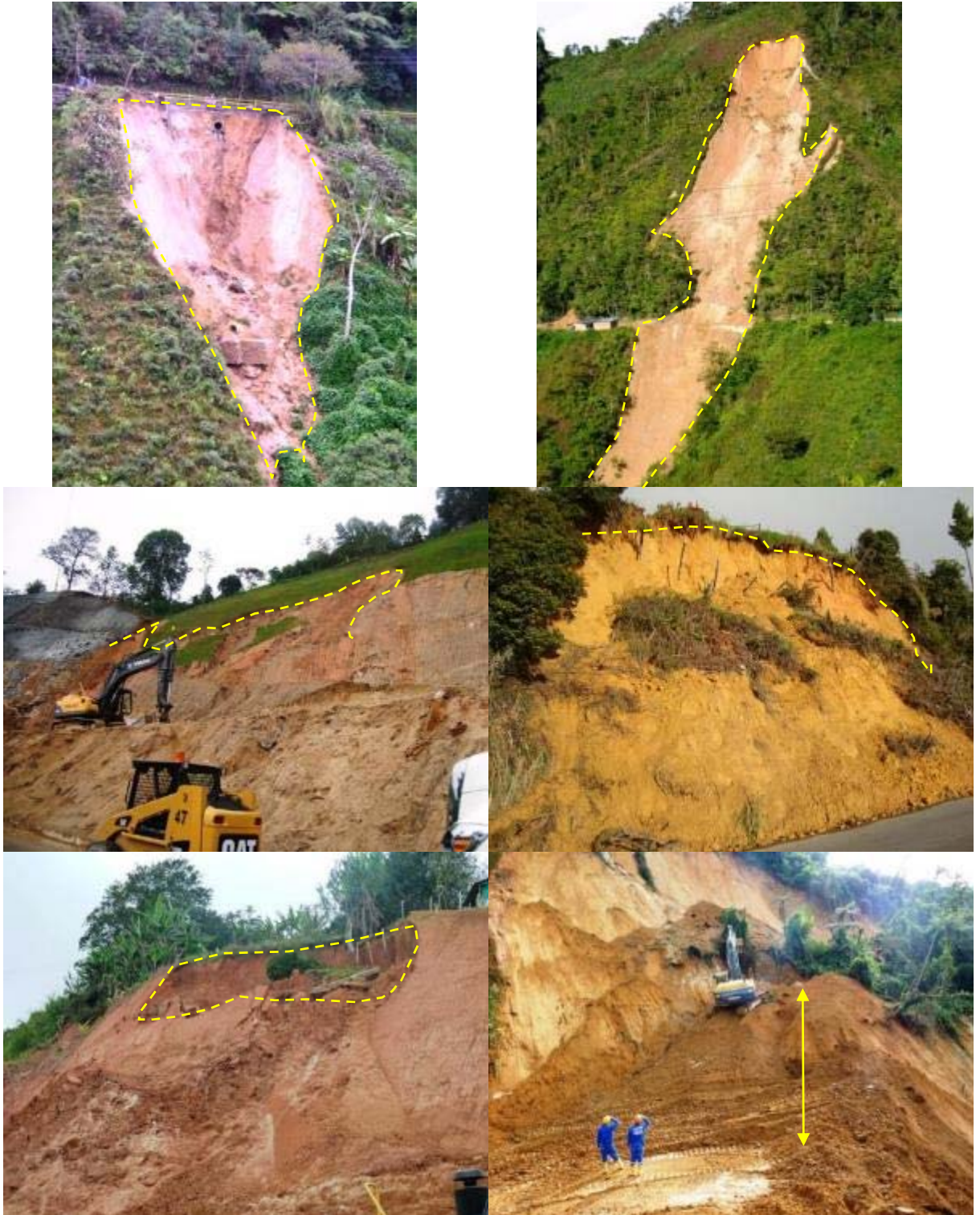
Fotografía 7. Deslizamientos típicos con presencia de gruesas capas de suelos residuales en el macizo de Santander.
