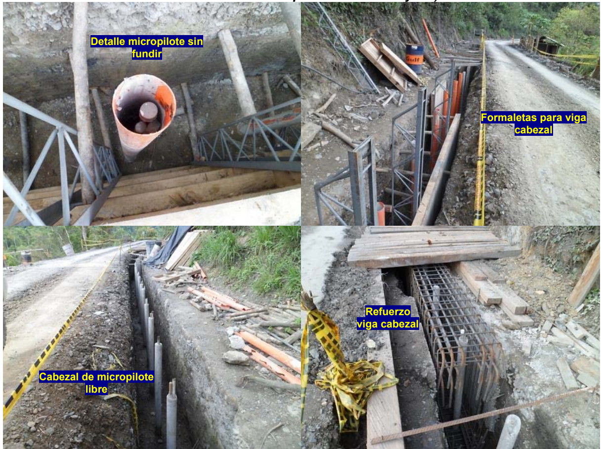
Fotografía 3. Ejemplo de construcción de micropilotes en carretera (ampliación de calzada Vía Pauna - Otanche departamento de Boyacá).
