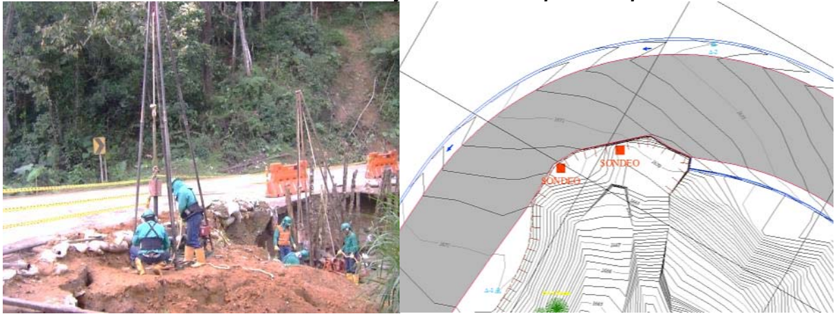
Ilustración 39. Vista de labores de sondeo y localización en planta respecto a la cárcava.
