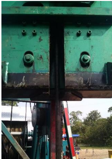
Figura 31. Proceso de instalación con cabeza inyectora de la unida C_TECH 250.
