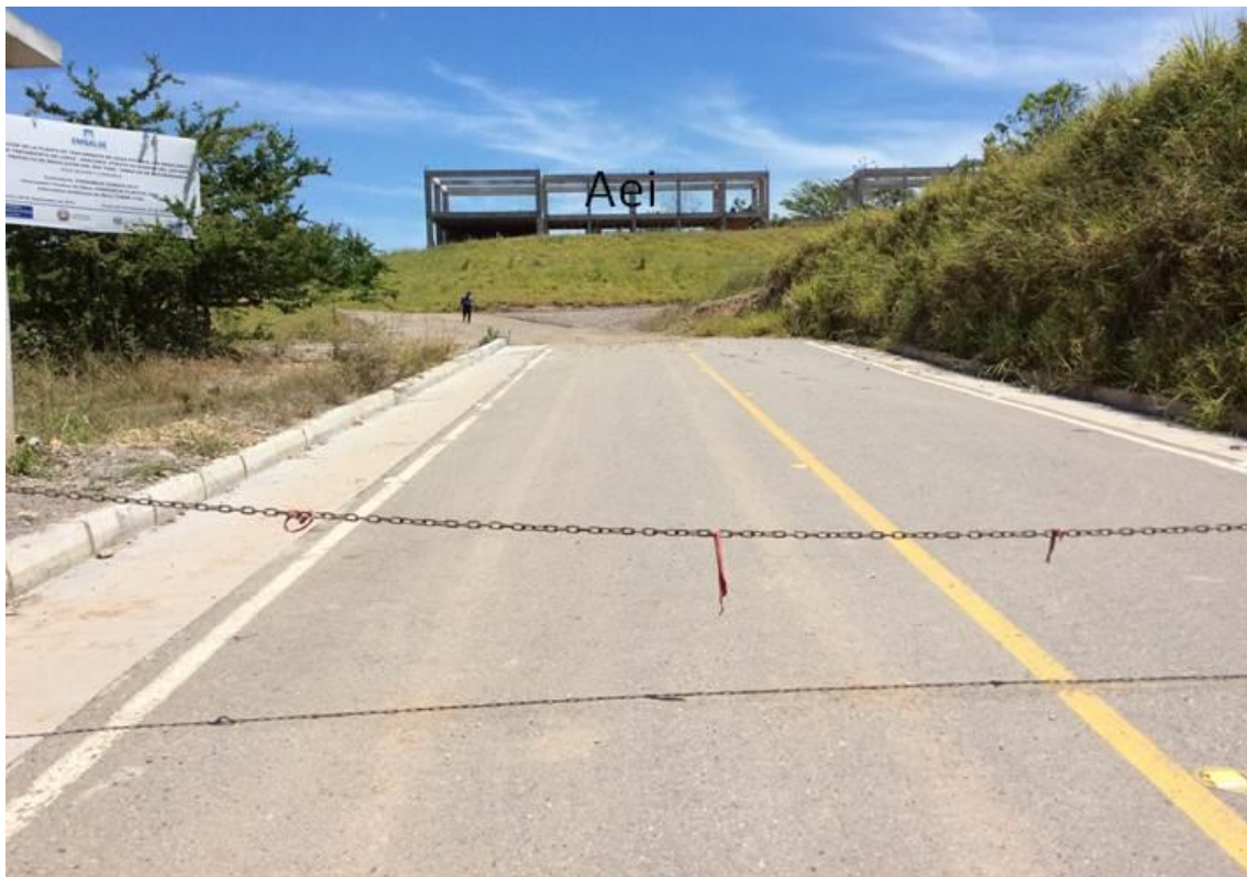
Figura 47. Se evidencia plata de tratamiento de agua, ubicada al sur este de la zona de estudio. Fotografía pereciente al archivo del proyecto.
