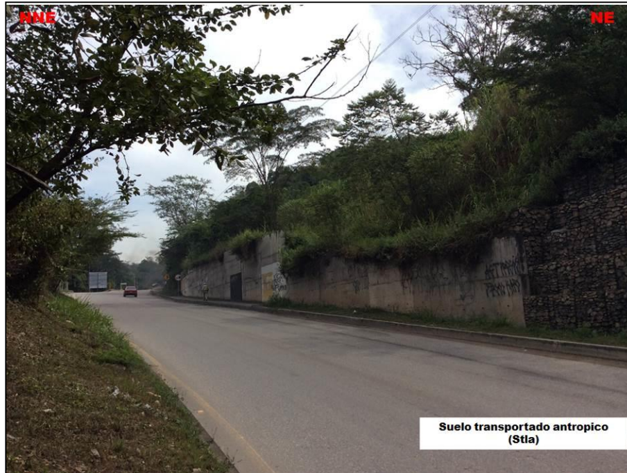
Figura 20. Suelo transportado de ladera antrópico (Stla). Punto de control Panorámico. E: 1104849 m, N: 1283513 m. fotografía pereciente al archivo del proyecto. Azimut 30°.
