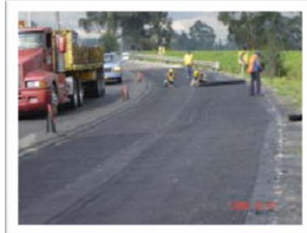
Figura 3. Refuerzo de capas asfálticas
