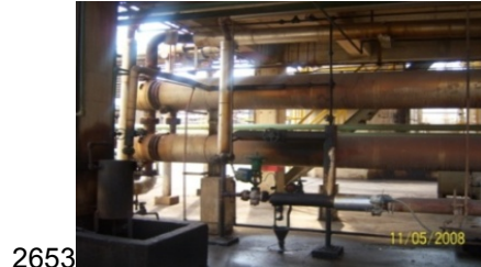
Figura 6. Fotografía del estado actual del punto de muestreo de ACPM/ DMO T-2653.
