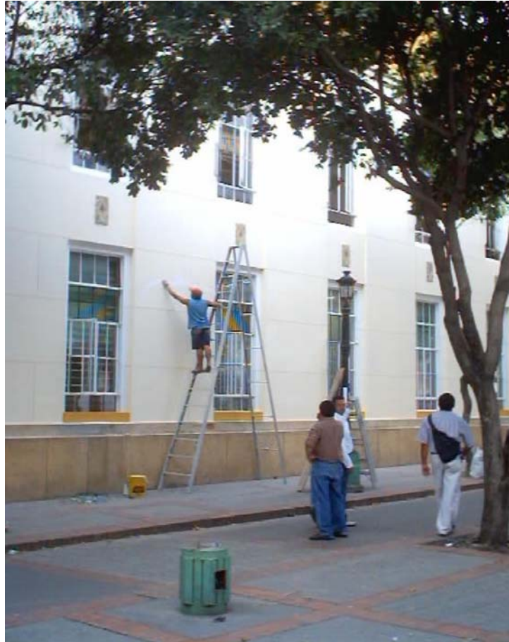
Figura No. 6 Terminación Arreglo Fachada Oriental Gobernación de Santander
