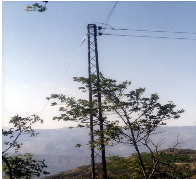
Figura No. 2 Torre Metálica Red Alta Tensión Vereda Carare, Barichara Santander.
