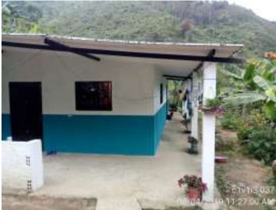
Figura 8. Frente de la vivienda C1V1I3-37.
