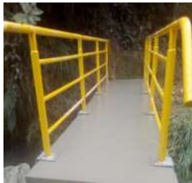
Figura 16. Estado del puente posterior a la intervención
