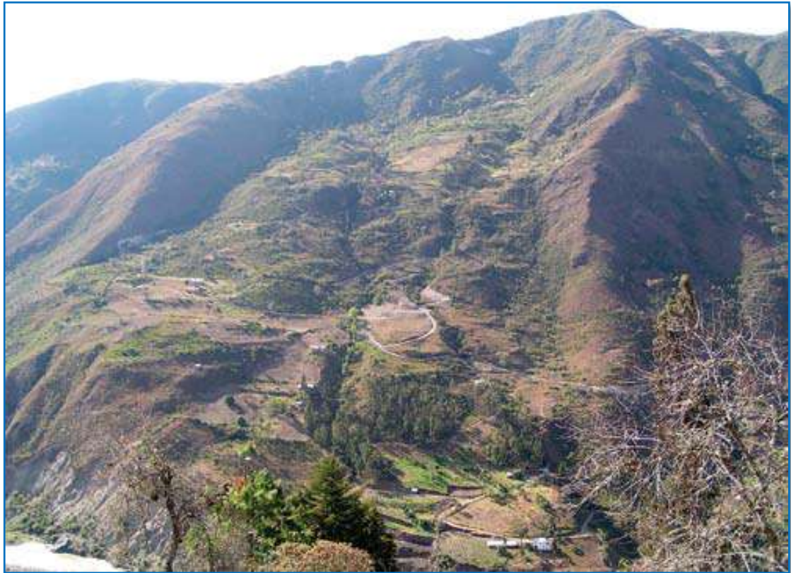
Figura 11. Deslizamiento Rotacional, Cerro Mizhquiyacu, Ecuador, 1993.
